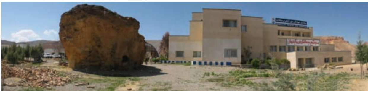
شکل ۵-۵- مجتمع آبگرم محلات
