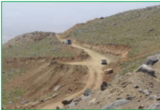
شکل ۵۹-۱- احداث راه در مراتع
