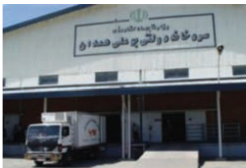
شکل ۲-۶- سردخانه بوعلی - همدان
