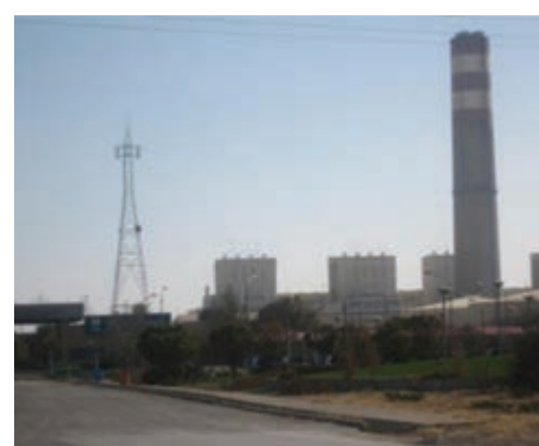
شکل ۱۹-۵- نیروگاه برق شهید مفتاح - فامنین
