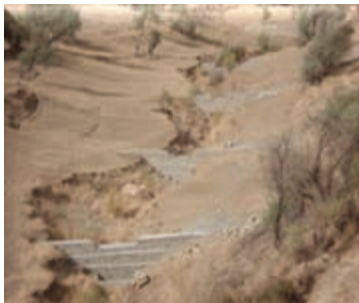
شکل ۱-۶۳- بند گابیونی (سنگ‌ها در تور سیمی)
