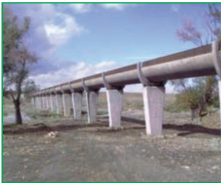
شکل ۱-۴۵- کانال انتقال آب (سیاه کمر)
