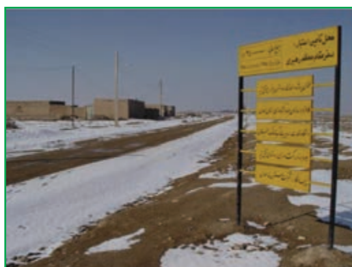
شکل ۶-۶- پروژه احداث راه روستایی - آق تپه
