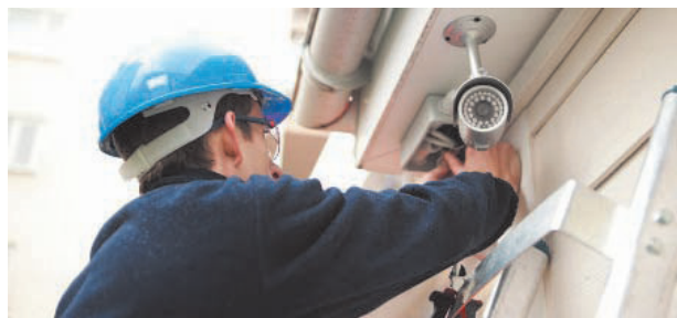
شکل ۲۹- نصب دوربین در فضای مناسب
