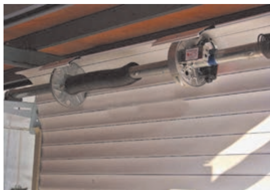
شکل ۱۱- محل نصب موتور کرکره‌ای
