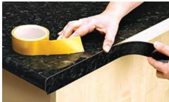
شکل ۱۱۹ - نصب نوار لبه صفحه تاپس
