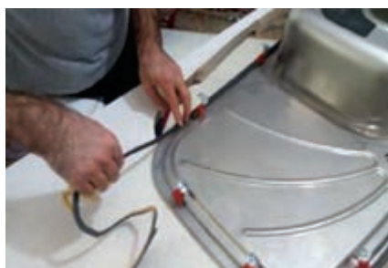
شکل ۱۰۴ - نصب نوار آب بندی پشت لبه سینک
