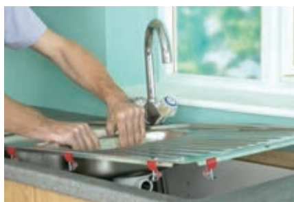
شکل ۱۰۵ - نصب سینک به کمک گیره های بست (کلیپس اتصال)
