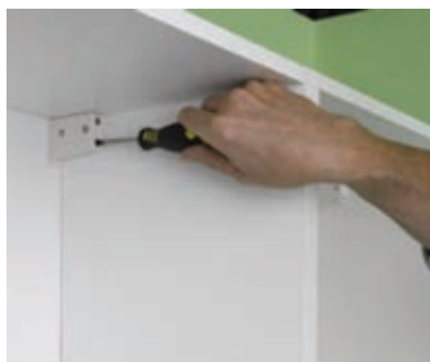
شکل ۲۳ - نصب کابینت با هنگر
