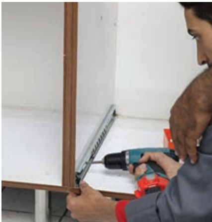
شکل ۸۲ - نصب قطعه یک تکه روی بدنه‌ها
