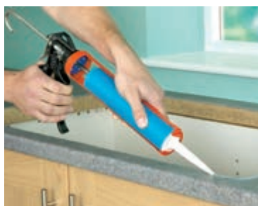
شکل ۱۰۳ - آب بندی لبه های زیرین سینک به کمک چسب آکواریوم
