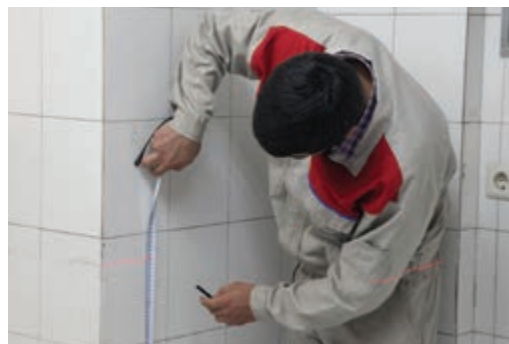
شکل ۹ - اندازه‌گذاری روی دیوار آشپزخانه برای ترسیم خط تراز
