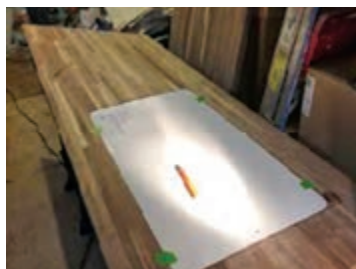
شکل ۹۹ - نصب شابلون برشی روی صفحه کابینت و خط کشی طرح برش
