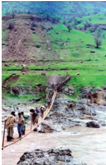
نمونه‌هایی از طرح و اجرای پل نفررو
