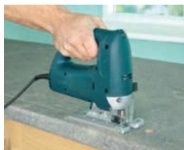
شکل ۱۰۱ - برش کاری محل قرارگیری سینک
