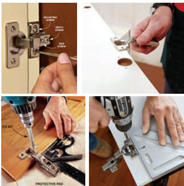
شکل ۴۹- نصب لولا روی در
