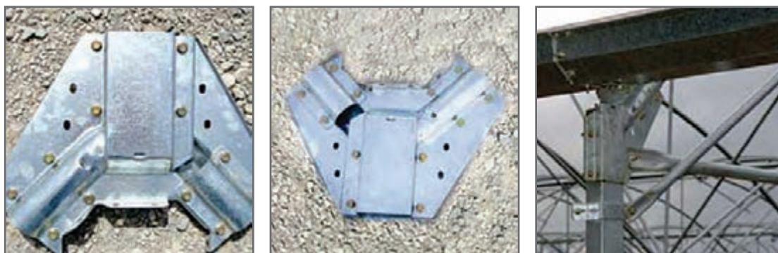
شکل ۷- اجزای اتصالات گلخانه
