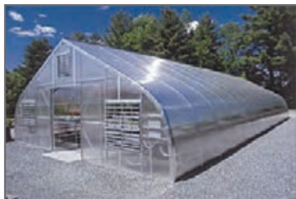
شکل ۲۱- گلخانه با سقف گنبدی
