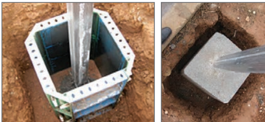
شکل ۸- فونداسیون سازه گلخانه
