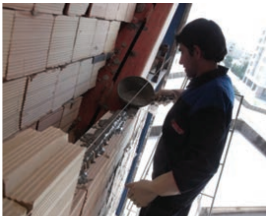
شکل ۴-۶- ملات ماسه سیمان جهت اتصال بلوک‌ها
