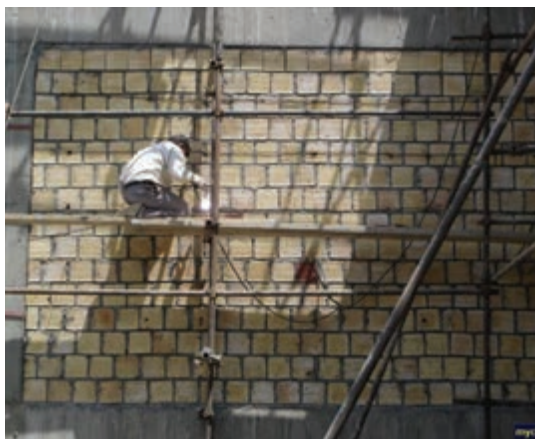
شکل ۴-۳- اجرای دیوار خارجی با بلوک سفالی
