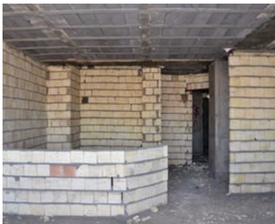
شکل ۴-۴- تیغه چینی داخلی با بلوک سفالی
