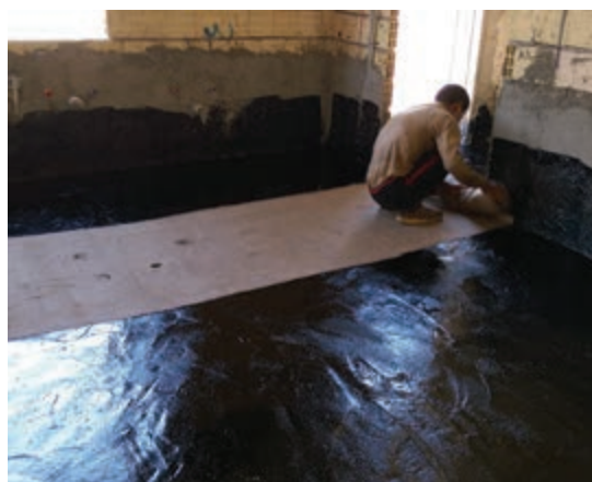
شکل ۴-۱۱- اجرای قیرگونی کف فضای داخلی
