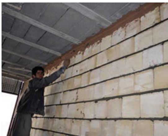
شکل ۲-۴- اجرای دیوار چینی با بلوک سفالی
