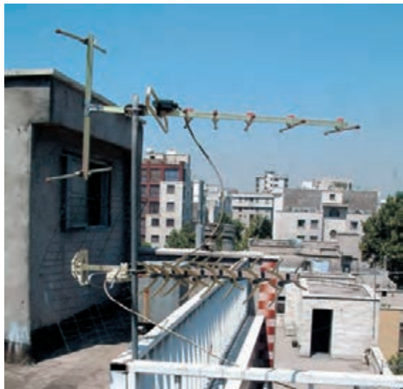
شکل ۱-۶۹- آنتن VHF و UHF روی دکل
