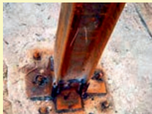
اتصال نامناسب و ضعیف ستون به بیس پلایت
