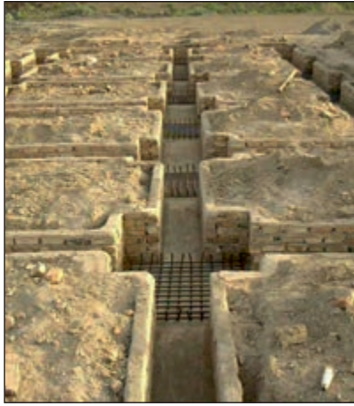
شکل ۴۸-۱ آرماتورگذاری پی تکی کلاف بندی شده
