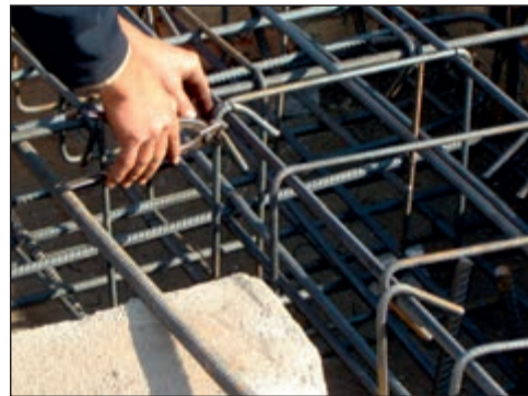
شکل ۲-۱۴۱ بستن خاموت دور آرماتور اصلی شناژ
