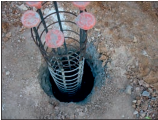
شکل ۱-۷۳ پی چاهی در حال اجرا
