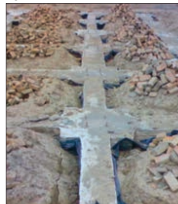
شکل ۷۳-۲ پی و شناژ بعد از بتن ریزی
