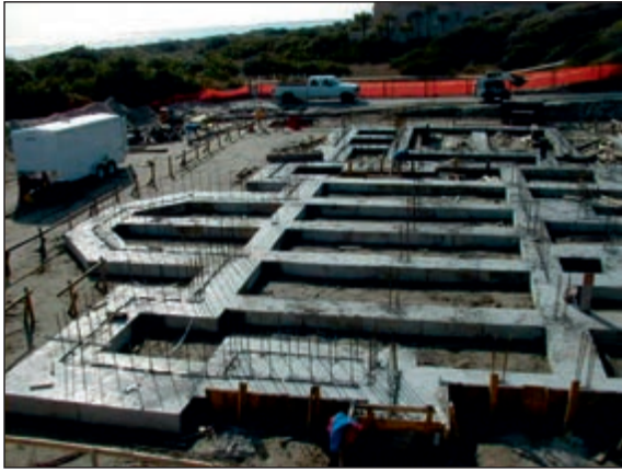
شکل ۱-۵۶ پی بتن مسلح نواری شبکه ای زیرستون
