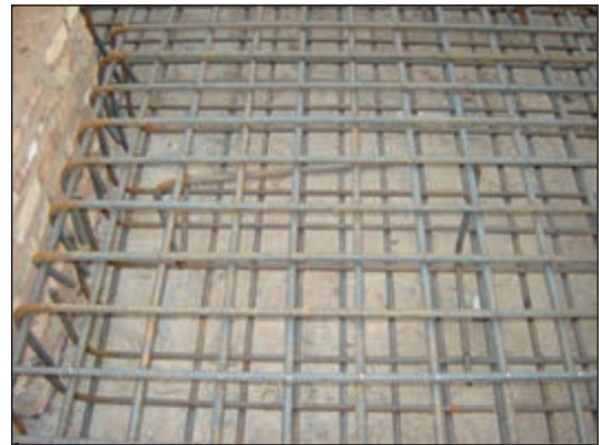
شکل ۱۴۷-۲ پی نواری و آرماتورگذاری آن
