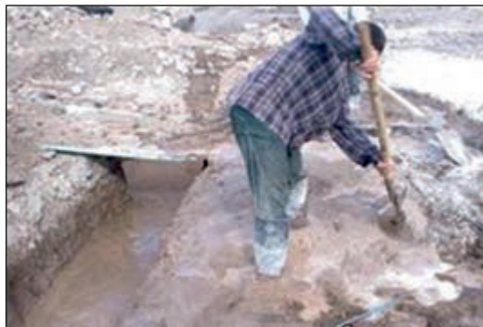
شکل ۱-۳۱ اجرای شفته آهک در فونداسیون
