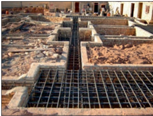
شکل ۷۰-۲ میلگردگذاری در پی کلاف بندی
