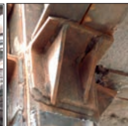
اتصال تیر به ستون به صورت لچکی
