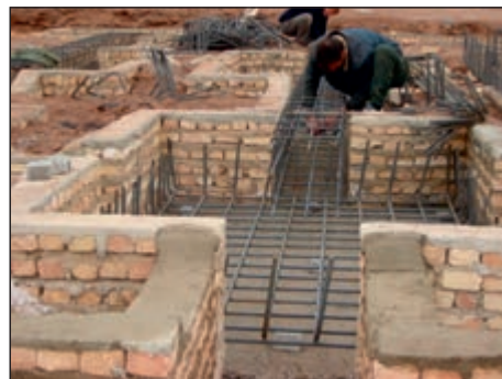
شکل ۱-۸۲ قالب‌بندی آجری در اطراف پی
