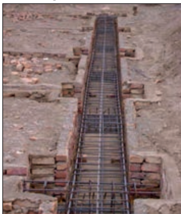
شکل ۷۲-۲ پی و شناژ قبل از بتن ریزی
