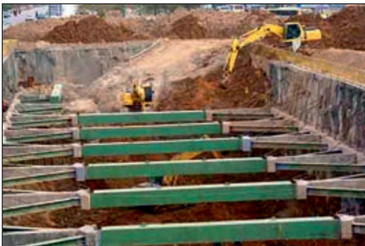
شکل ۸۹-۱ مهاربندی با پشت بندهای افقی و مایل (فضایی)
