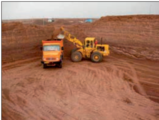
شکل ۱-۸۵ گودبرداری با لودر در زمین نامحدود
