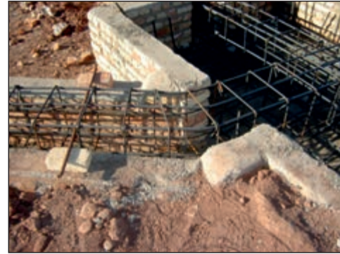
شکل ۲-۱۴۳ آرماتورهای شناژ و پی
