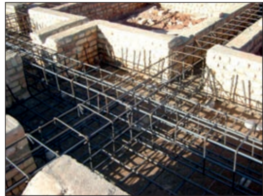
شکل ۷۱-۲ عبور میلگردهای شناژ در پی
