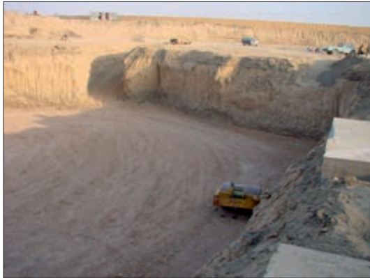
شکل ۱-۸۴ زمین گودبرداری شده
