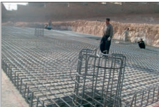
شکل ۱۵۲-۲ آرماتورگذاری پی صفحه‌ای با ستون‌های بتنی
