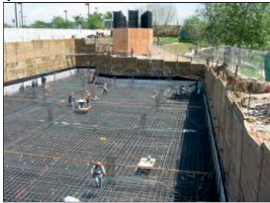
شکل ۱-۶۲ پی بتن مسلح یکپارچه (رادیه ژنرال)
