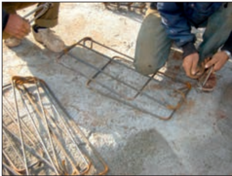
شکل ۲-۱۴۰ خم آرماتور و ساخت خاموت
