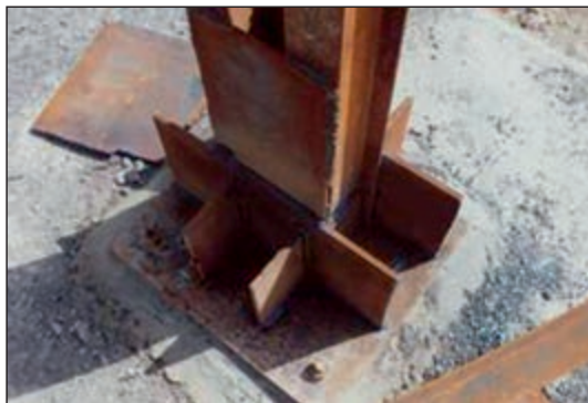
شکل ۱۶۸-۲ اتصال گیردار
