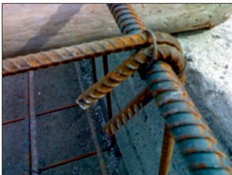
شکل ۲-۱۴۲ قلاب سرخاموت و بستن آن با مفتول
