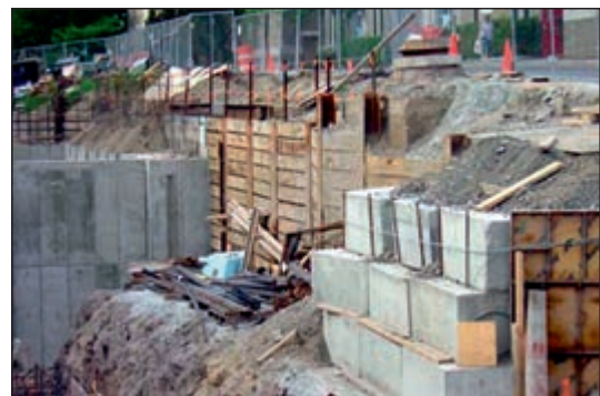
شکل ۹۱-۱ مهاربندی با دیوار مانع چوبی
