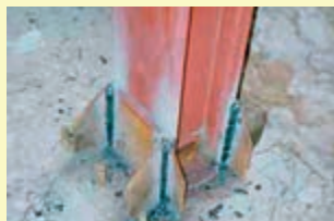
اتصال مناسب و جوش صحیح
