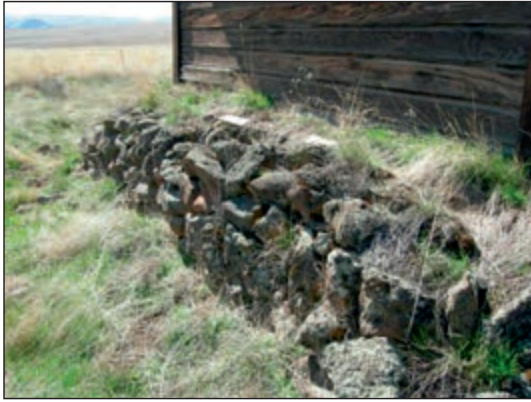
شکل ۱-۳۲ پی سنگی با سنگ لاشه
