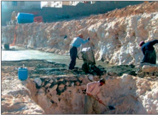
شکل ۸۷-۱ گودبرداری دستی (با بیل و کلنگ)
