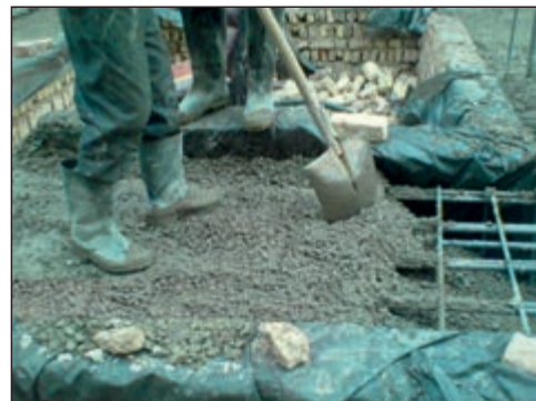
شکل ۲-۱۴۵ مرحله ی بتن ریزی داخل پی
