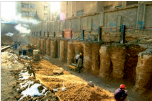
شکل ۸۸-۱ مهاربندی با پشت بند خاکی ستونی
