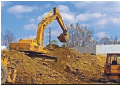
شکل ۱-۱۳- کندن زمین با وسایل مکانیکی
