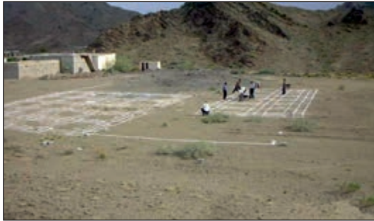
شکل ۱-۸۳ پیاده کردن نقشه روی زمین
