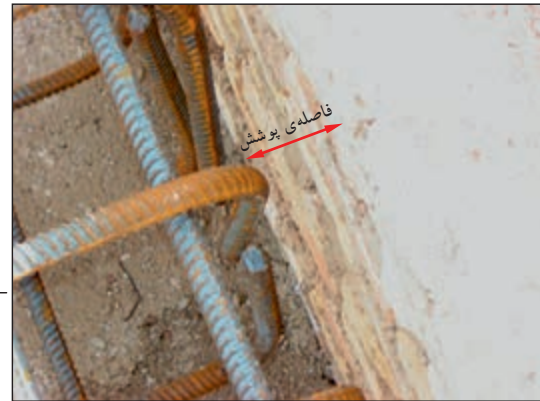
شکل ۱۲۶-۲ فاصله‌ی پوشش و قلاب سر میل‌گردها
