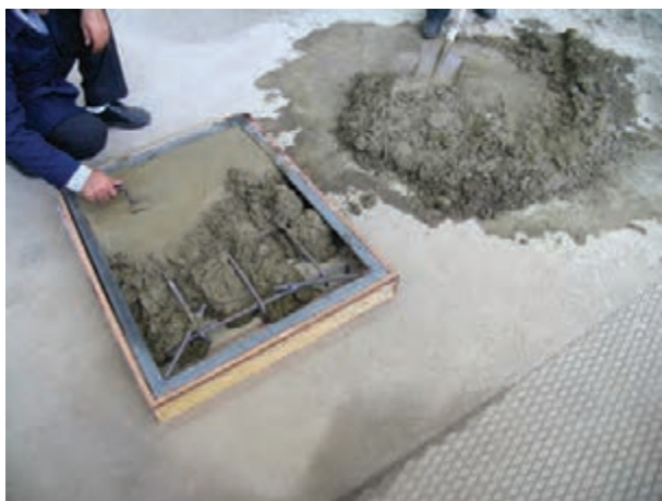
شکل ۶-۱- پر کردن قالب با ملات مناسب
