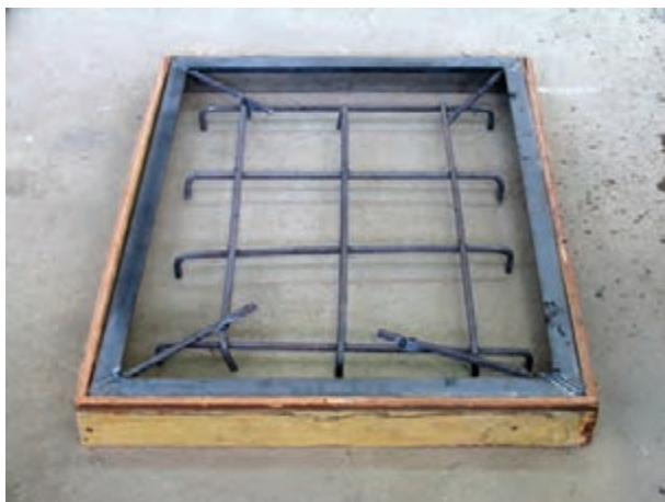
شکل ۵-۱- قرارگیری میل‌گردها در قالب
