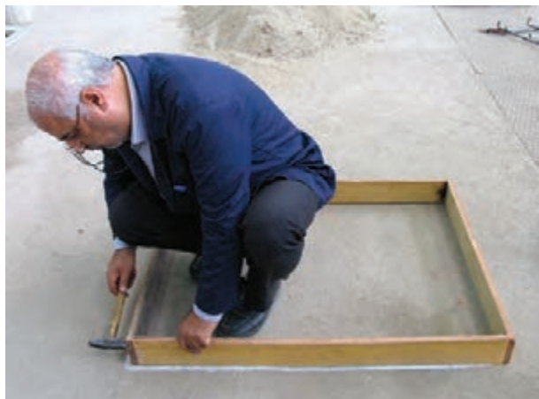
شکل ۴-۱- قالب بندی فونداسیون
