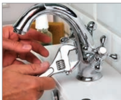
شکل ۲- بررسی و تعمیر شیر آب
