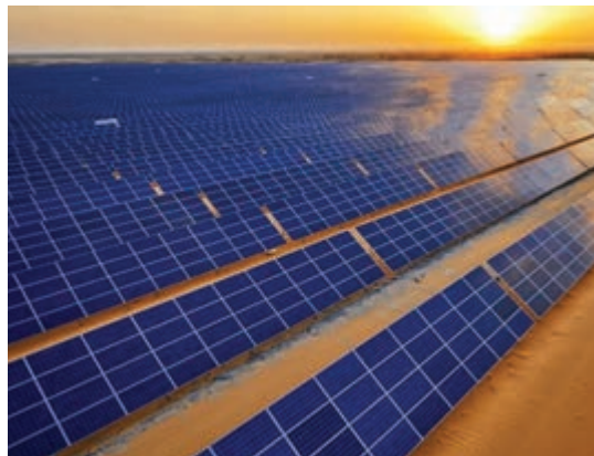
شکل ۵- نیروگاه تولید برق خورشیدی
