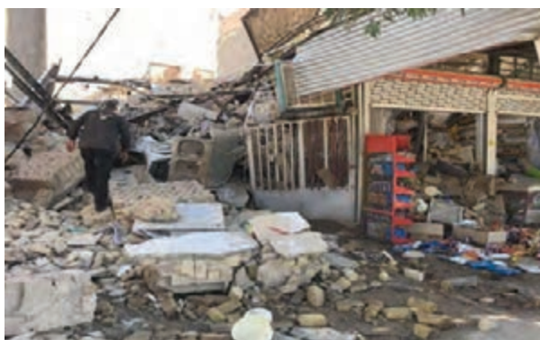
شکل ۱- زلزله ۷ ریشتری کرمانشاه
