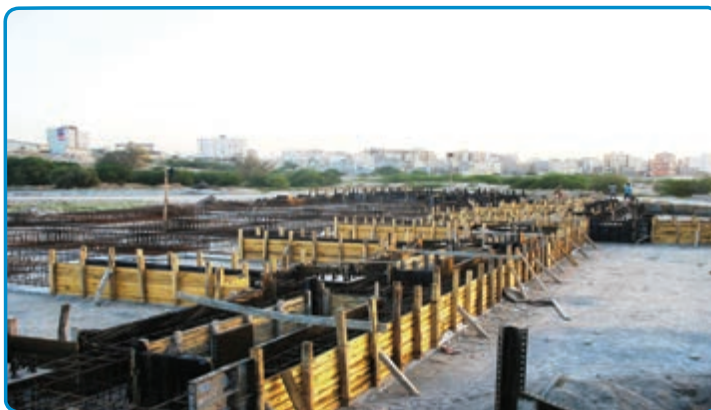
شکل ۳-۲۷- قالب چوبی برای اجرای پی
