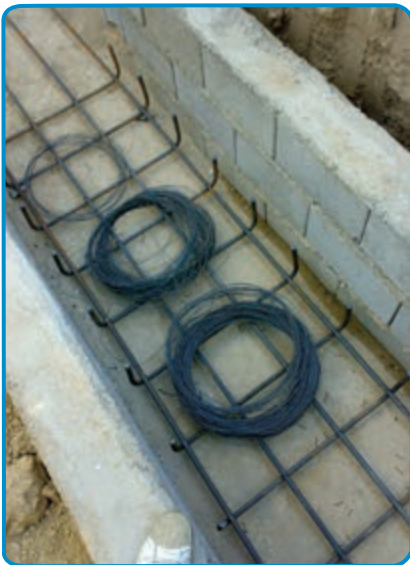
شکل ۹-۷- بهم بستن میلگردها
