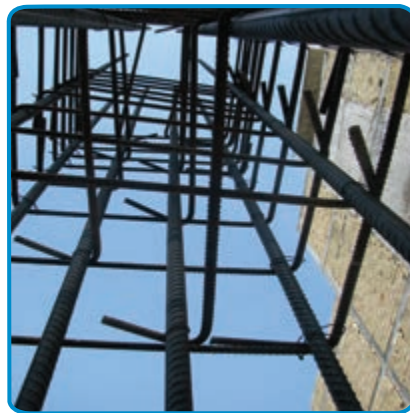
شکل ۱۹-۷- کار گذاشتن میلگردهای انتظار ستون، در فونداسیون
