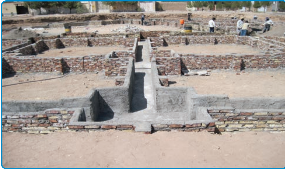
شکل ۳-۲۹- قالب آجری برای اجرای پی
