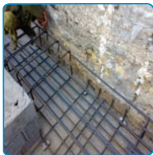
شکل ۱۲-۷- میلگردگذاری شبکه بالای
