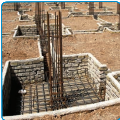
شکل ۴-۷- اجرای میلگردهای ریشه انتظار
