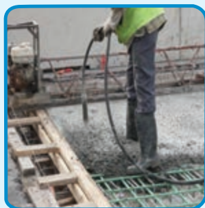
شکل ۱۴-۳- ویبراتور یا لرزاننده بتن داخل قالب
