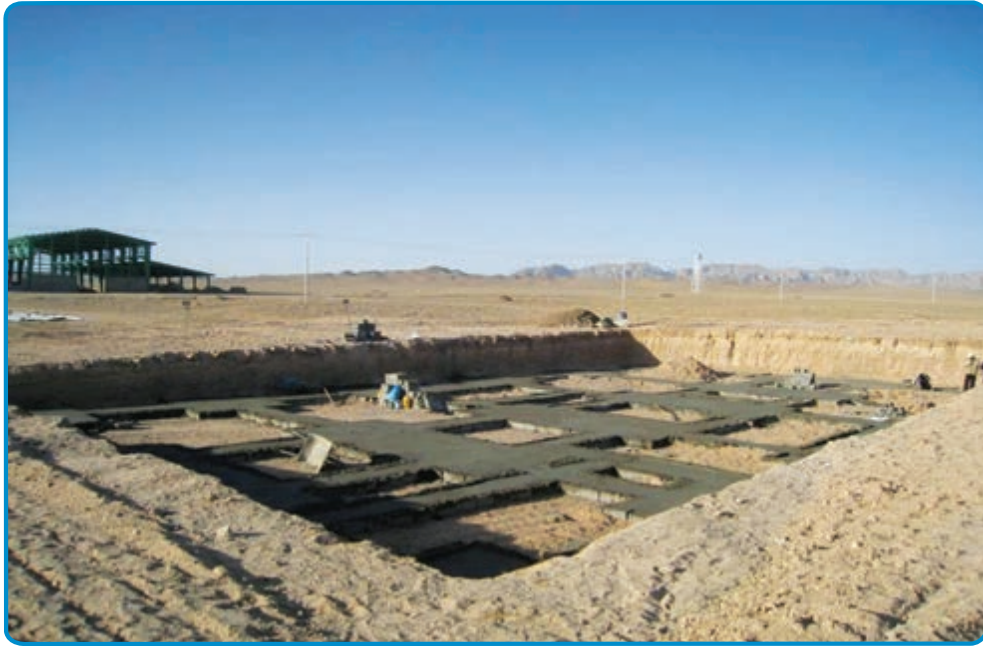
شکل ۳-۶- گودبرداری در زمین‌های نامحدود
