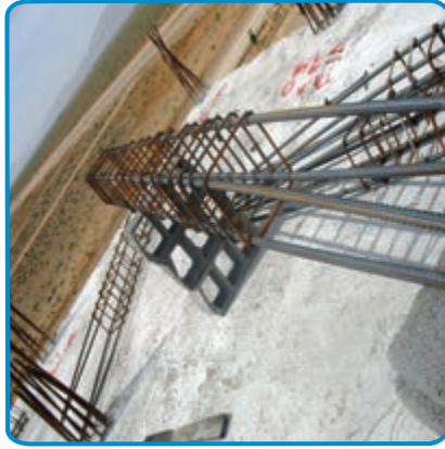
شکل ۷-۲۲- آماده کردن میلگردهای تیر روی زمین
