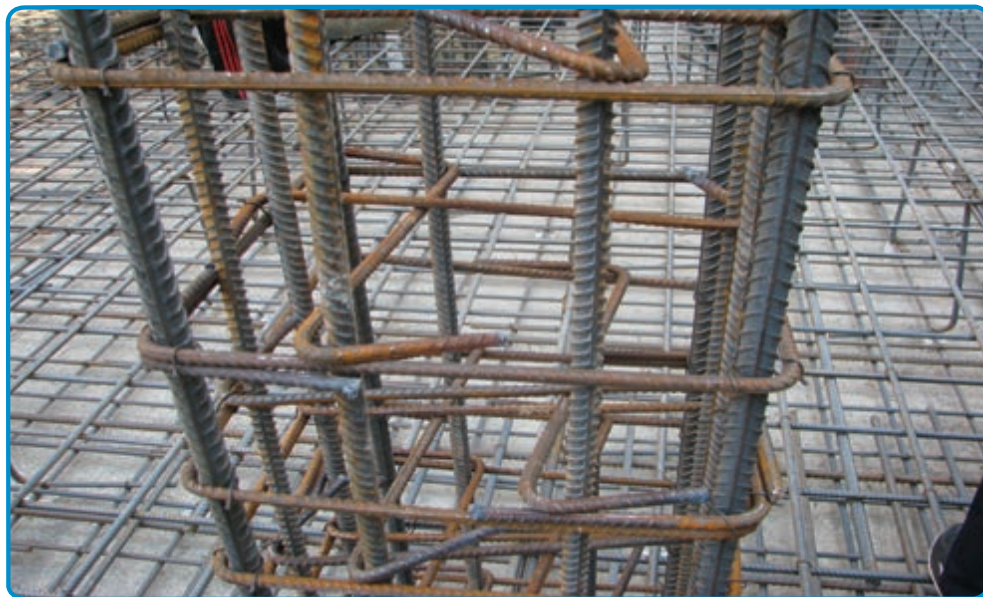
شکل ۵۰-۳- کاربرد سنجاقک در میلگرد گذاری ستون
