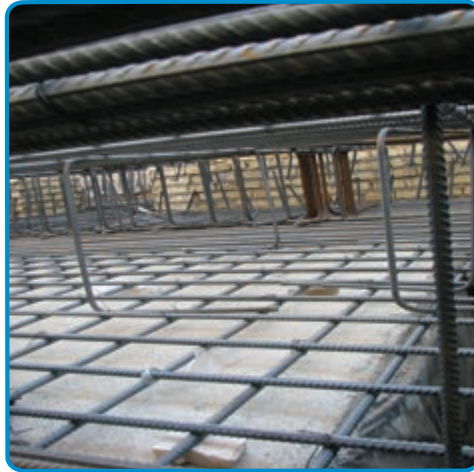
شکل ۳-۵۳- استفاده از خرک در میلگرد گذاری پی
