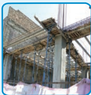
شکل ۳-۳۹- استفاده از قالب چوبی برای اجرای تیر
