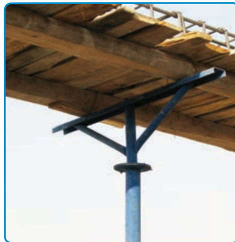
شکل ۲۱-۳- استفاده از شمع‌های فلزی جهت نگهداری قالب‌ها
