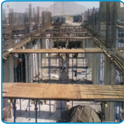
شکل ۷-۲۱- قالب بندی تیرها
