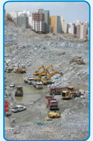
شکل ۳-۷- گودبرداری در زمین‌های نامحدود
