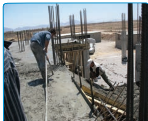
شکل ۴۲-۷- بتن ریزی دال پله
