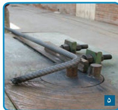
شکل ۳-۶۴ - خم کردن میلگرد
