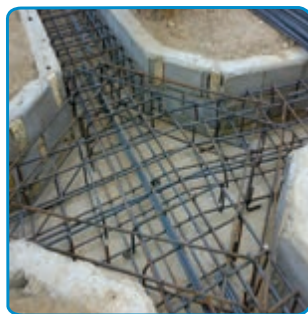
شکل ۱۴-۷- تکمیل میلگردگذاری محل اتصال ستون
