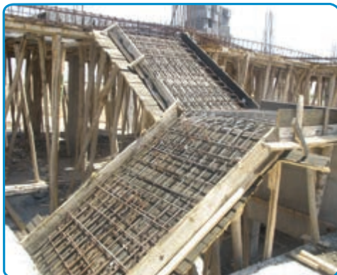
شکل ۳۹-۷- اجرای میلگردهای دال پله
