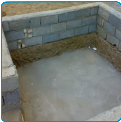
شکل ۱-۷- آماده سازی کف پی
