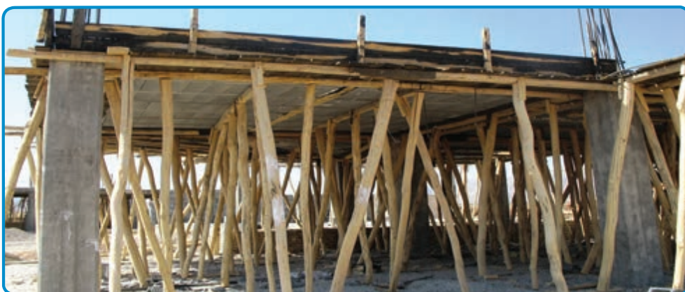
شکل ۲۴-۳- استفاده از شمع‌های چوبی جهت نگهداری قالب‌ها
