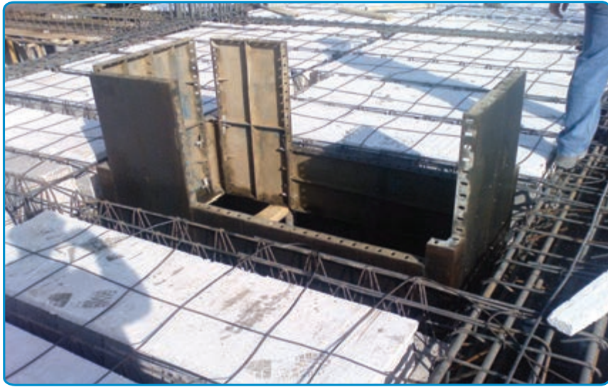
شکل ۳۵-۷- تکمیل قالب بندی
