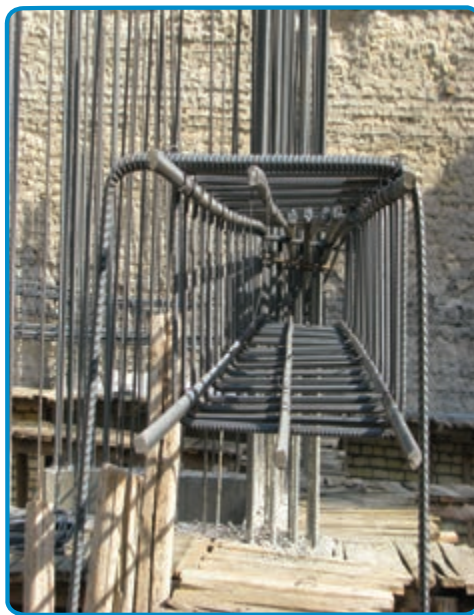
شکل ۳-۴۵- میلگرد طولی در تیر
