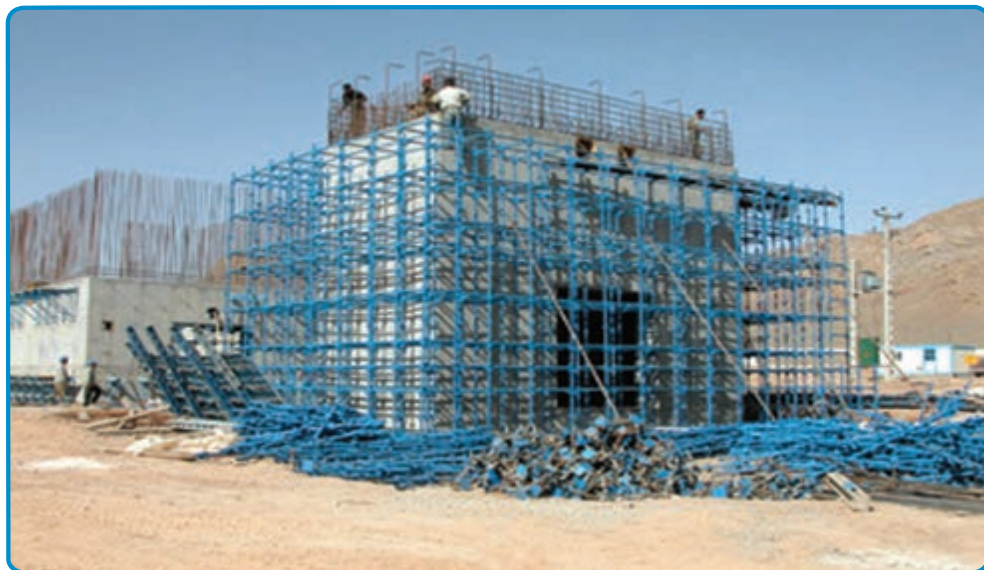
شکل ۳-۲۶- داربست فلزی
