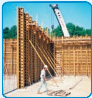
شکل ۱۹-۳- اجرای دیوار بتنی فایبر گلاس برای
