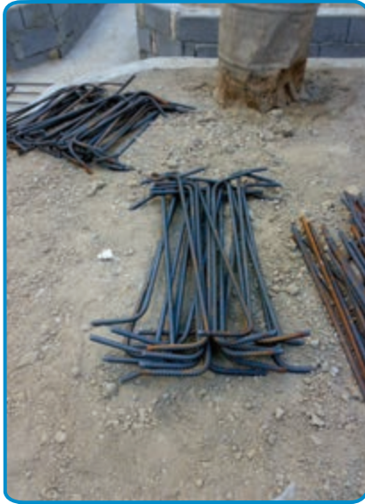
شکل ۷-۷- آماده کردن میلگردهای طولی و عرضی
