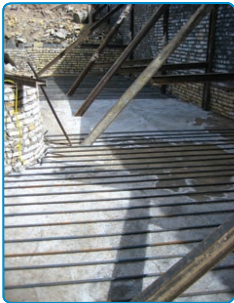
شکل ۳-۴۶- میلگرد طولی کف پی
