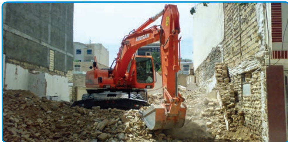
شکل ۳-۲- خاکبرداری با ماشین
