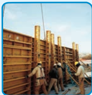
شکل ۳-۳۶- قالب فایبر گلاس برای اجرای دیوار بتنی
