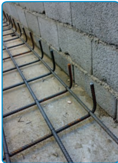
شکل ۱۰-۷- رعایت پوشش بتن در کف و بدنه
