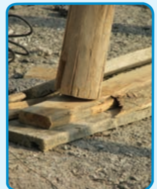
شکل ۲۵-۳- استفاده از گوه جهت تنظیم ارتفاع
