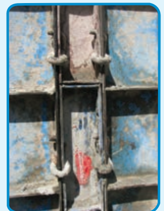
شکل ۱۳-۳- پشت بند قالب
