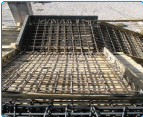
شکل ۳۷-۷- اجرای میلگردهای دال پله
