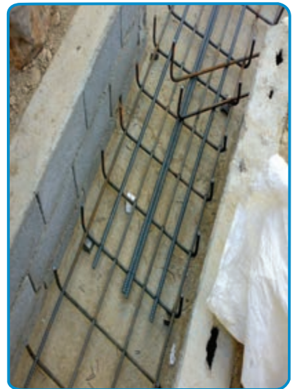
شکل ۱۱-۷- قرار دادن میلگردهای تقویتی
