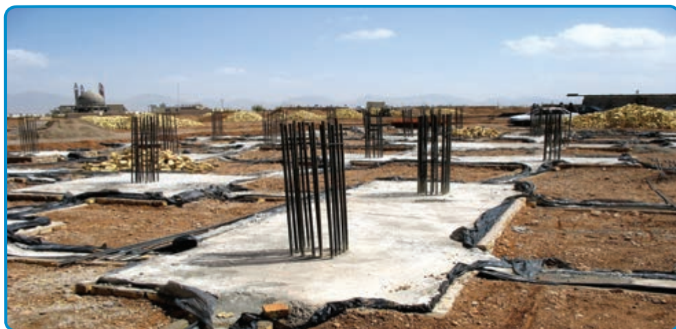
شکل ۱۰-۳- استفاده از پلاستیک در پی
