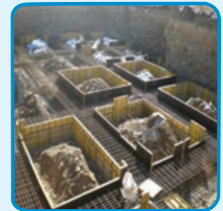
شکل ۳-۳۱- قالب فایبرگلاس برای اجرای پی
