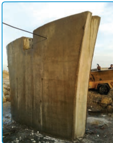
شکل ۳-۴۲- قالب برداری
