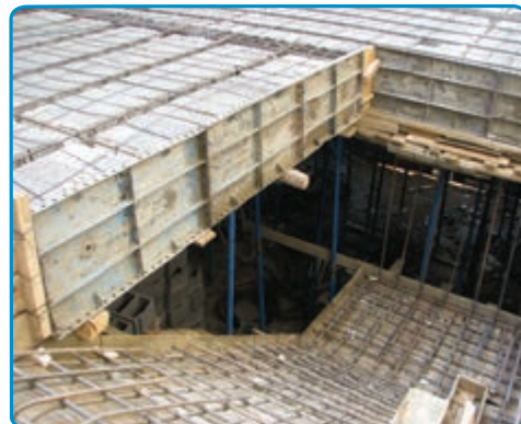
شکل ۴۰-۷- اجرای میلگردهای دال پله
