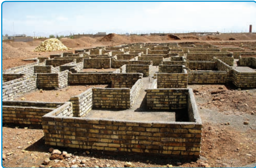
شکل ۱۵-۳- استفاده از قالب آجری برای اجرای پی
