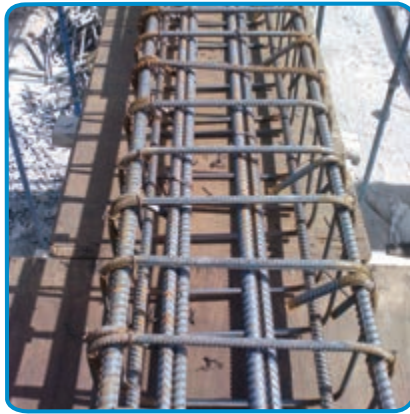
شکل ۷-۲۵- بستن خاموت ها با مفتول
