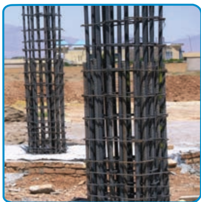
شکل ۱۶-۷- بتن ریزی ستون
