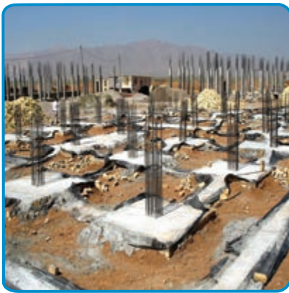
شکل ۱۷-۷- اجرای خاموت و سنجاقک
