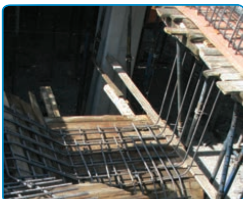
شکل ۴۱-۷- اجرای میلگردهای دال پله
