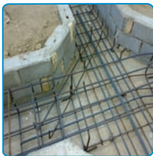
شکل ۱۳-۷- قرار دادن میلگردهای تقویتی پخها
