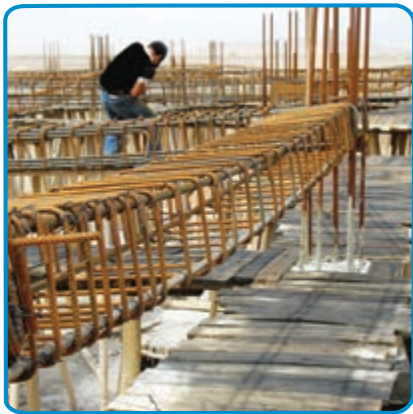
شکل ۷-۲۴- تنظیم فاصله بین خاموت ها
