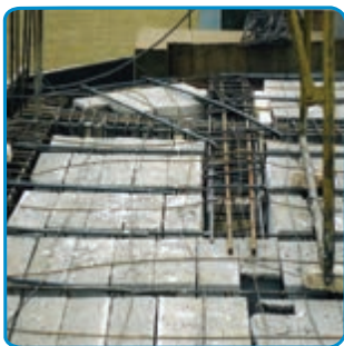
شکل ۷-۳۲- اجرای تیرهای فرعی کنسول
