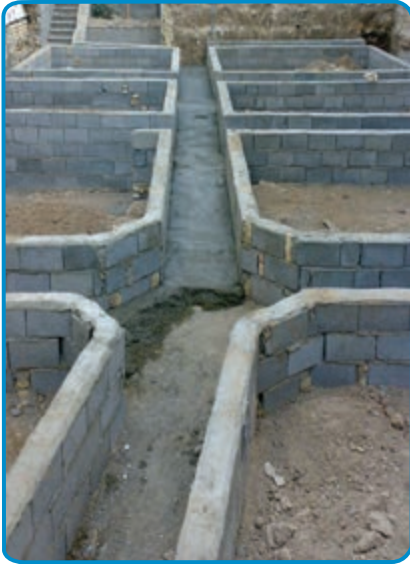
شکل ۶-۷- آماده سازی کف پی
