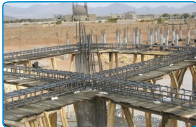
شکل ۷-۲۷- رعایت فاصله پوشش بتنی در کف
