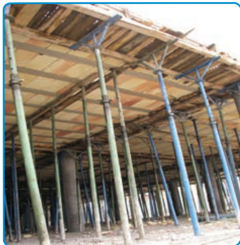
شکل ۲۱-۳- استفاده از شمع‌های فلزی جهت نگهداری قالب‌ها
