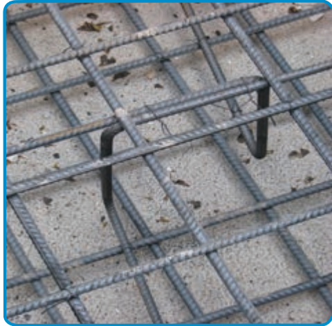
شکل ۳-۵۳- استفاده از خرک در میلگرد گذاری پی
