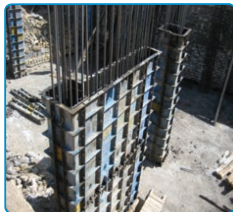
شکل ۳-۳۵- قالب فلزی برای اجرای دیوار بتنی
