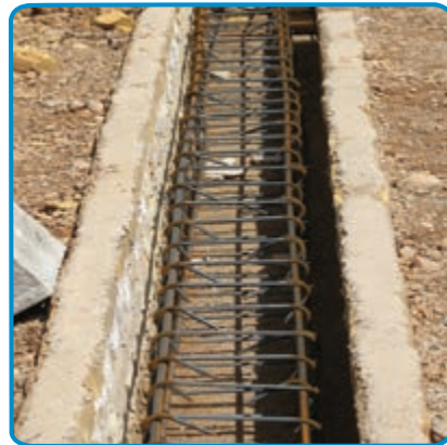
شکل ۵-۷- اجرای میلگرد شناژها
