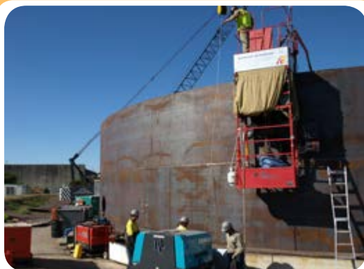
م) کارگاه ساخت مخازن ذخیره
