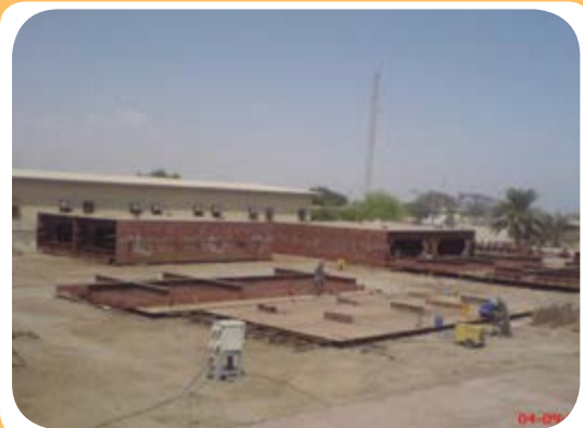
د) کارگاه ساخت اسکلت فلزی ساختمان
