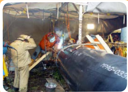
ن) کارگاه ساخت خط لوله
