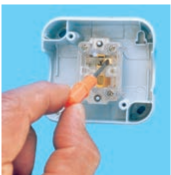
د - برقراری اتصال پلاتین با کنتاکت غیرمشترک ۲
