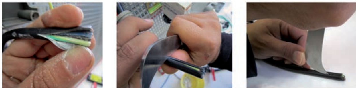
شکل ۲-۲۲ - بریدن و لخت کردن کابل
