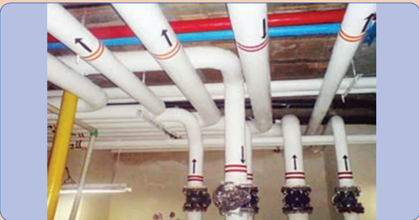
شکل ۱۴- موتورخانه با رنگ آمیزی نهایی و فلش و نوار رنگی
