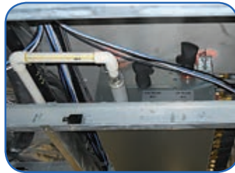
شکل ۸- نمونه اتصال لوله تخلیه به تشتک
