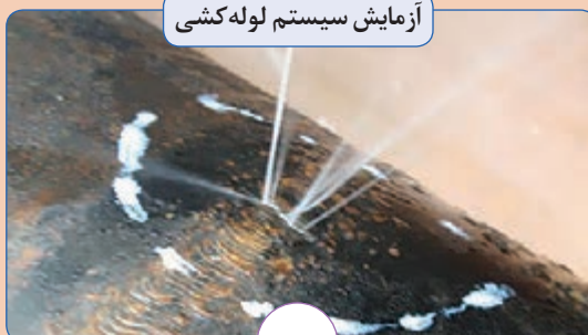
آزمایش سیستم لوله کشی
