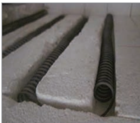
شکل ۱۳- نصب المنت درون شیار
