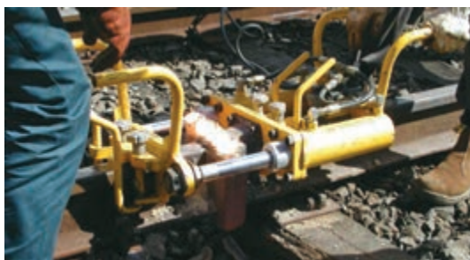
شکل ۲۴- برش گرده اضافی جوش
