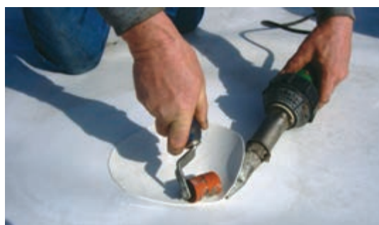
شکل ۱۱- جوشکاری با گاز داغ به صورت دستی
