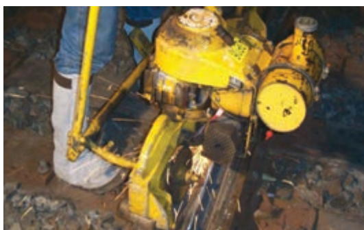
شکل ۲۵- سنگ زنی و پرداخت کاری سطح گرده
