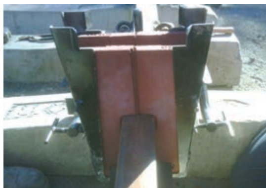
شکل ۱۸- نصب قالب اطراف ناحیه اتصال
