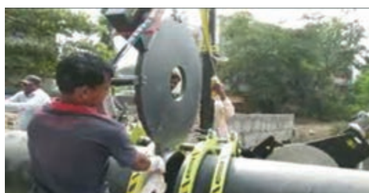
شکل ۱۸- جوشکاری لب به لب Butt Fusion
