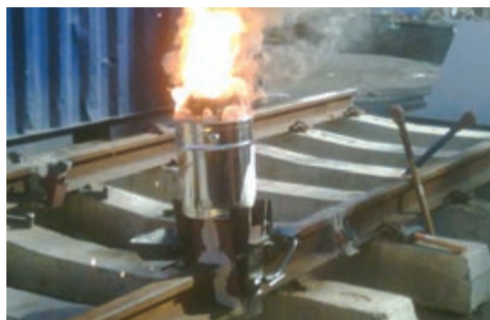
شکل ۲۱- نمایی از انجام واکنش ترمیت
