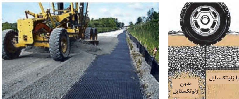
شکل ۲۵- کاربرد پارچه‌های ژئوتکستایل در زیرسازی راه
