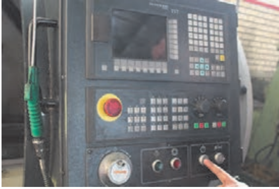
شکل ۱۹- روشن کردن سیستم هیدرولیک دستگاه
