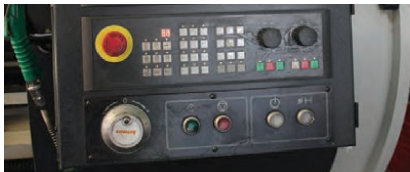
شکل ۱۶- قسمت اپراتوری سیستم کنترل
