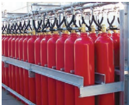
شکل ۳۸- سامانه اطفای حریق CO_2
