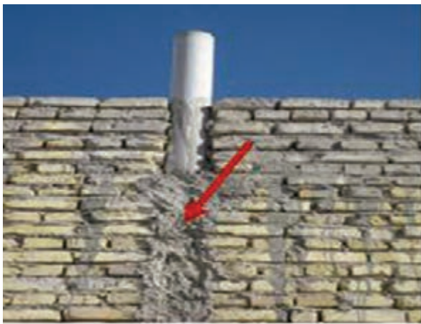
شکل ۱ - ۶۵: پر کردن درز لوله‌ها
