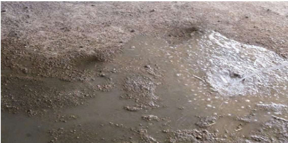
شکل ۱-۶۷: خیس کردن سطح زیر کار
