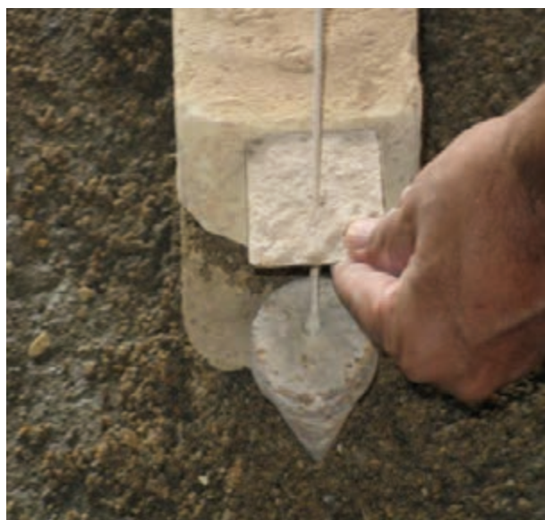
شکل ۱-۹۴: شاقول کردن نبش کار
