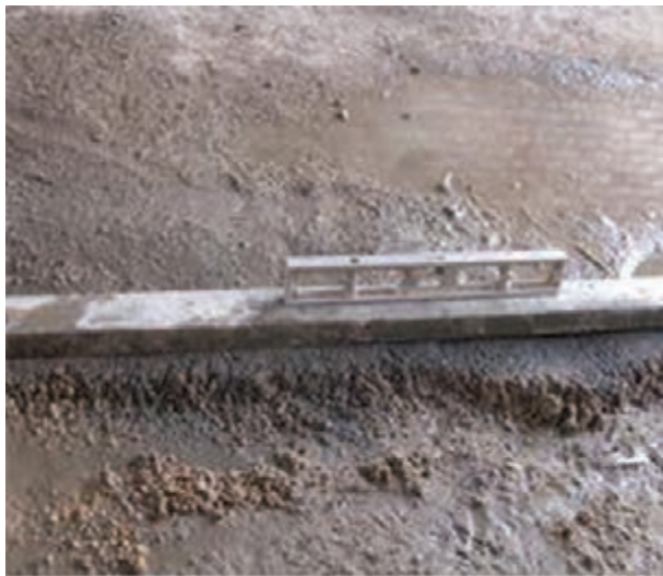
شکل ۱- ۶۹: تراز کردن روی ملات
