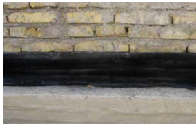
شکل ۱- ۳۰: دیوار روی کرسی چینی
