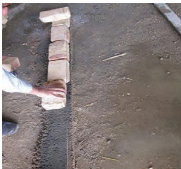
شکل ۱-۷۴: نحوه چیدن آجر در امتداد ریسمان کار
