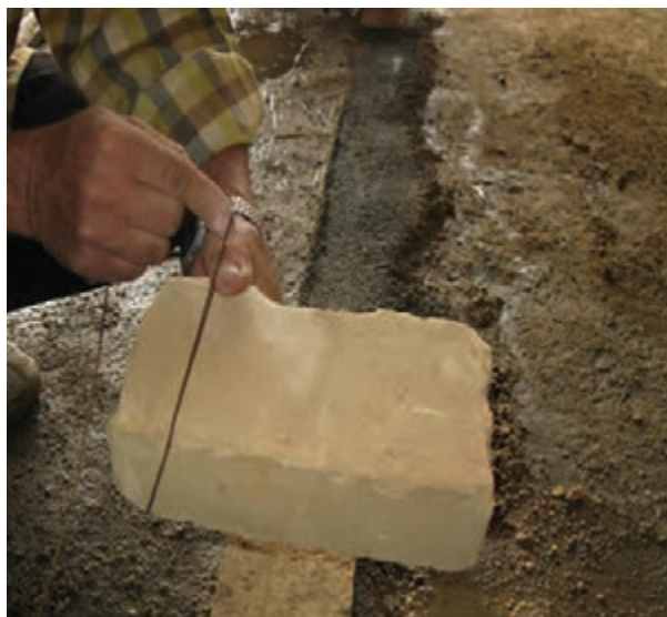
شکل ۱-۷۲: نحوه بستن ریسمان کار به آجر
