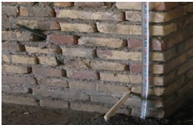
شکل ۳-۳۳: جدا کردن خط تراز روی دیوار
