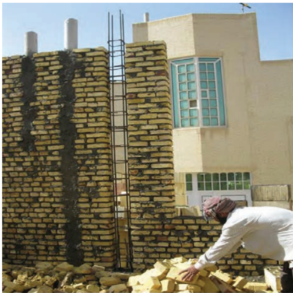
شکل ۱ - ۶۰: اتصال کلاف قائم و افقی در دیوار
