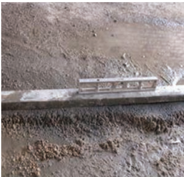
شکل ۱ - ۸۶: کنترل تراز سطح ملات
