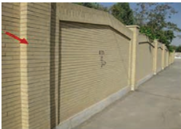
شکل ۱ - ۵۸ : وابند در دیوار حصارکشی
