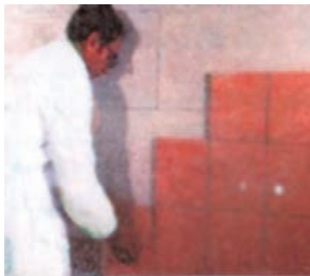
شکل ۱ - ۴۳: نصب کاشی روی قطعات پیش ساخته گچی
