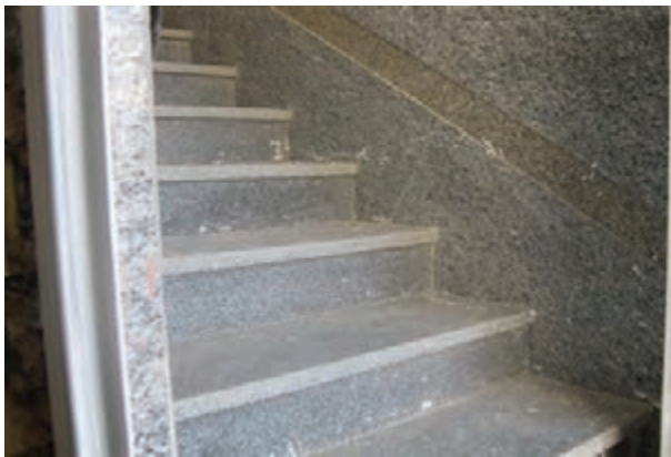
شکل ۱-۱۶ : کاربرد سنگ در نمای ساختمان
