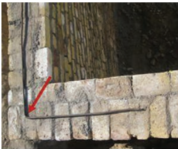
شکل ۱ - ۵۵: میلگرد گذاری در محل اتصال دو دیوار
