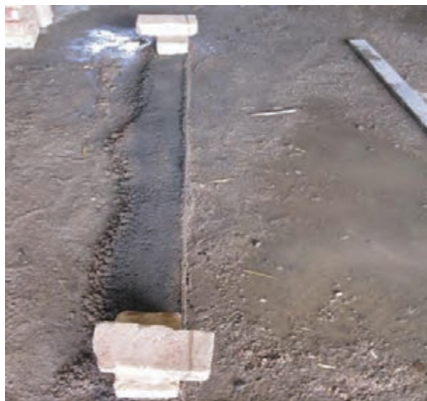
شکل ۱- ۹۰: بادخور نمودن ریسمان کار
