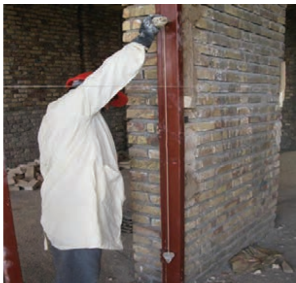
شکل ۳-۲۳: شاقول کردن وادار
