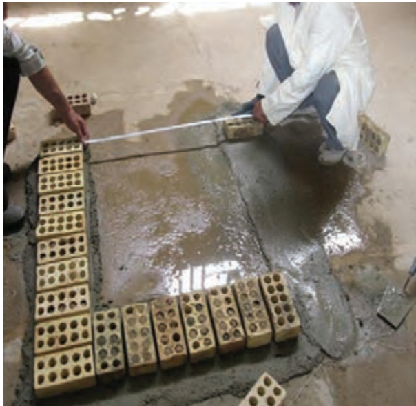
شکل ۱ - ۳۳ (ب): جدا کردن اندازه دو طرف دیگر
