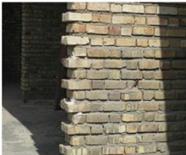
شکل ۱-۵۲: لابند در دیوار آجری
