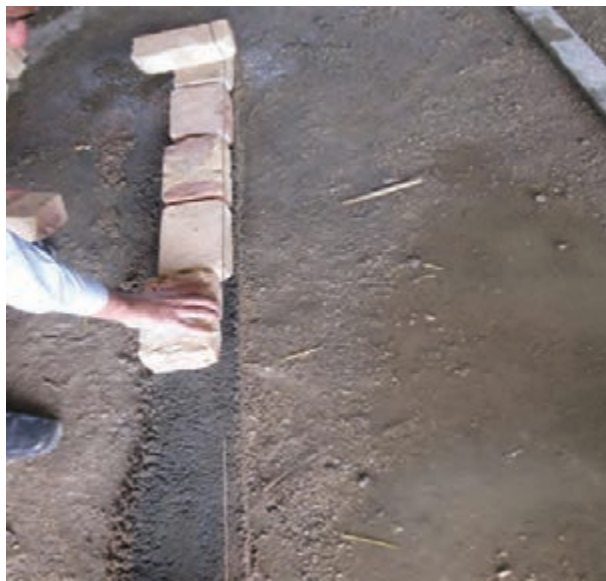
شکل ۱-۹۱: نحوه چیدن آجر در امتداد ریسمان کار
