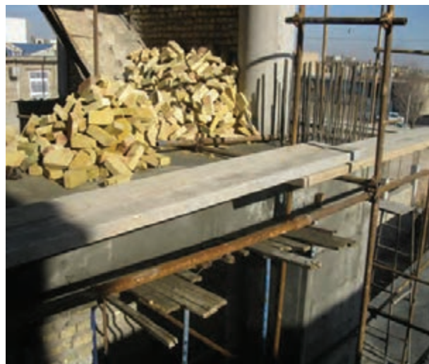
شکل ۱-۲: ضخامت مناسب برای تخته زیر پای
