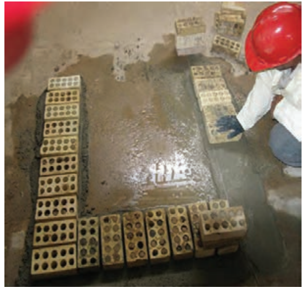
شکل ۱ - ۳۳ (ج): ریسمان کشی و چیدن ضلع سوم
