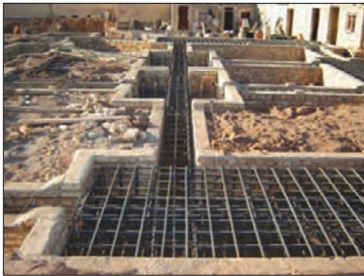
شکل ۳-۱۳۴ میلگردگذاری در پی کلاف بندی
