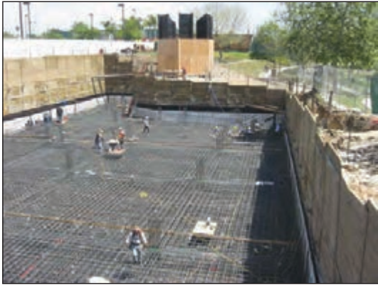
شکل ۳-۶۸ پی بتن مسلح یکپارچه (رادیه ژنرال)
