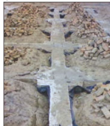
شکل ۳-۱۳۷ پی و شناژ بعد از بتن ریزی
