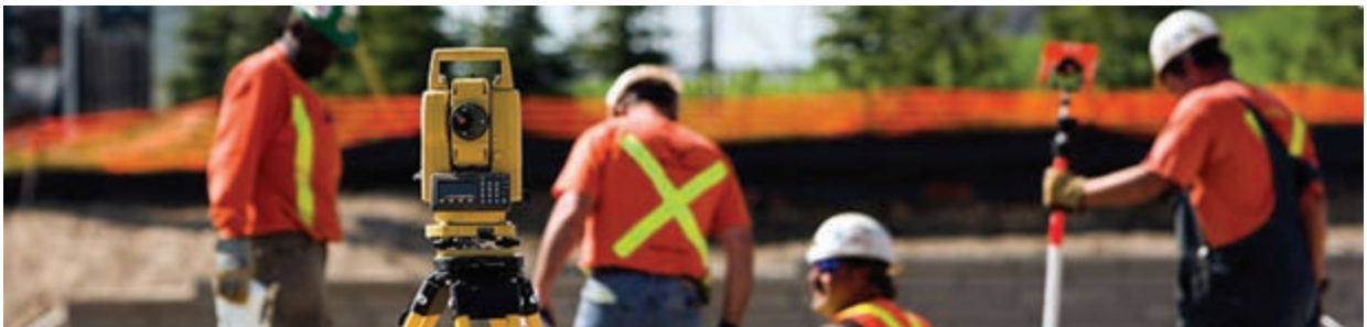
شکل ۴-۱. پیاده کردن با دوربین نقشه‌برداری
