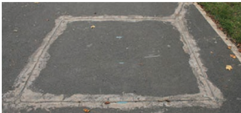
شکل ۲- نمونه نصب شده از حلقه‌های مغناطیسی
