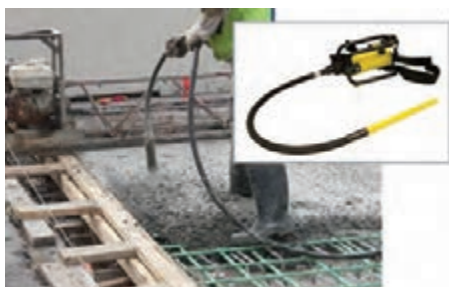
تراکم بتن تازه با دستگاه ویبره
