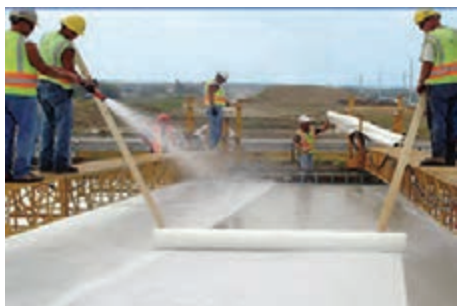
مرطوب کردن بتن و پوشش با نوار پلاستیکی
