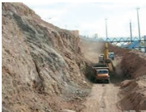
شکل ۱- اجرای عملیات خاک‌برداری
