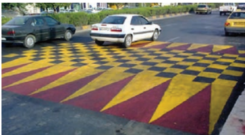
شکل ۲۵- نمونه‌ای از نحوه خط‌کشی سرعت‌کاه
