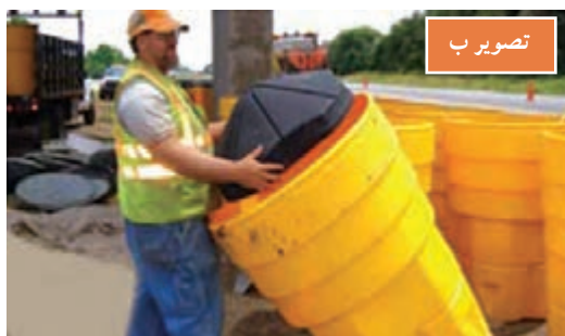
شکل ۲۲- چیدمان بشکه‌ها و قرار دهی مخروط درونی
