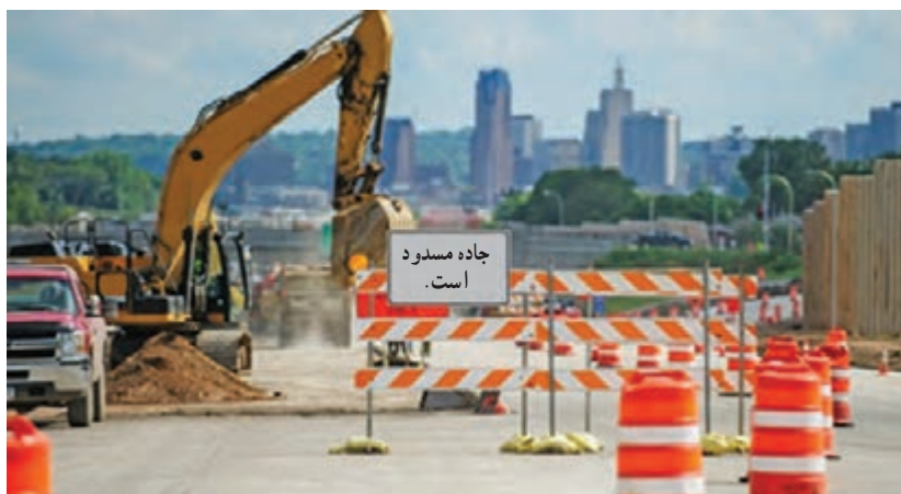
شکل ۳- حفاظت از جان کارگران و ماشین‌آلات با استفاده از علائم هشداردهنده و ضربه‌گیرها در محوطه کارگاهی
