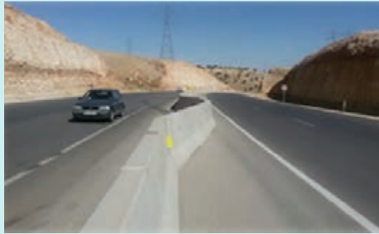
شکل ۵۵- وضعیت نیوجرسی بعد از تصادف با کامیون
