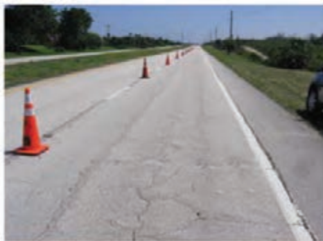
شکل ۳- ترک‌های بلوکی
