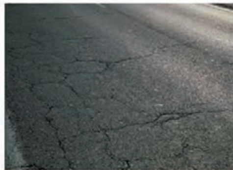
شکل ۳- ترک‌های بلوکی
