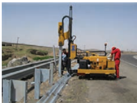
شکل ۴۴- پایه کوبی، نصب لقمه
