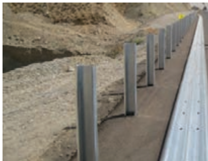
شکل ۴۲- پایه‌کوبی بعد از ریلی کردن سپری‌ها
