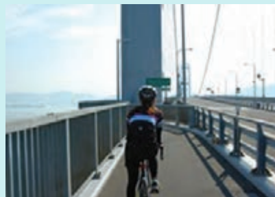
شکل ۷۷- ایمن سازی کناره های پل
