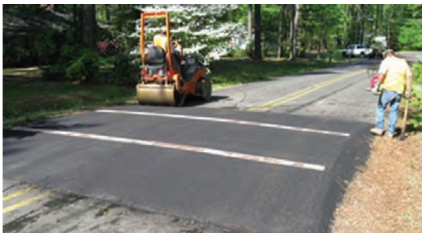
شکل ۲۴- غلتک زدن سطح سرعت‌گاه
