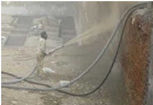
شکل ۲۰- اجرای بتن پاشی (شاتکریت) در بدنه سد
