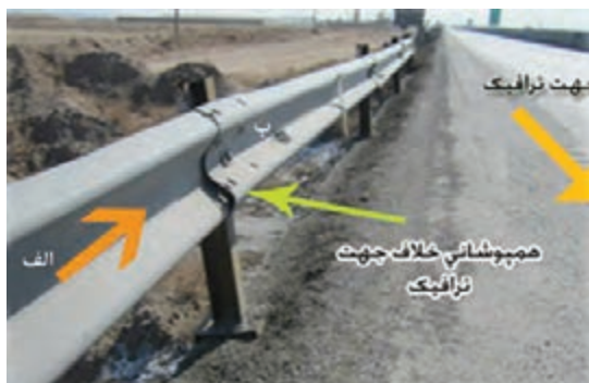
شکل ۴۱- جهت صحیح ریل کردن سپری
