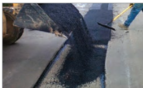
شکل ۴۰- روش ریختن و غلتک زدن
