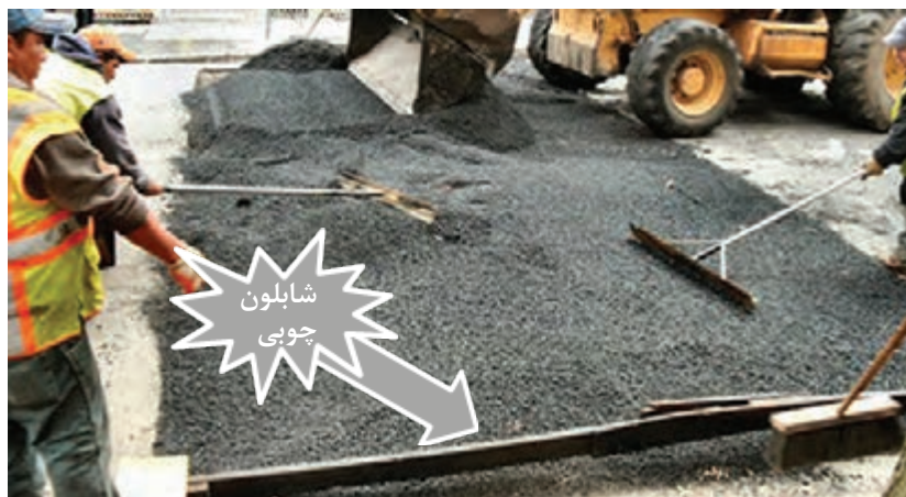
شکل ۲۳- اجرای سرعت‌گاه آسفالتی
