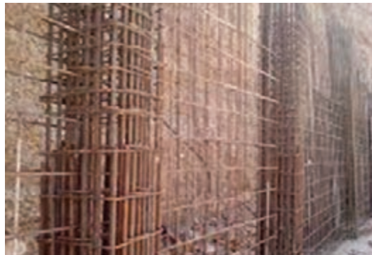
شکل ۲۰- اجرای بتن پاشی (شاتکریت) در بدنه سد
