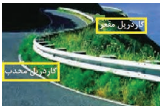
شکل ۶۵- اجرای گاردریل در مسیر محدب (خمیده) و مقعر (فرو رفته)
