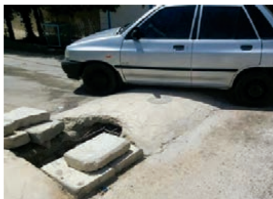
شکل ۹- ساخت سرعت‌گیر غیر استاندارد بتنی و آسفالتی
