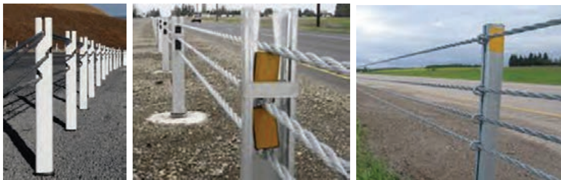
شکل ۱۸- نمونه‌هایی از انواع پایه های حفاظ کابلی
