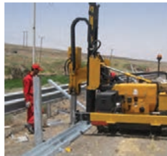
شکل ۴۲- پایه‌کوبی بعد از ریلی کردن سپری‌ها
