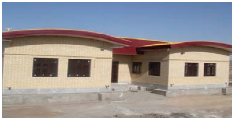
شکل ۳۲ - نمایی از یک راهدارخانه
