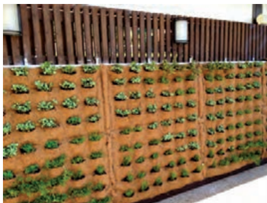
استفاده از الیاف طبیعی در ساخت دیوار سبز
