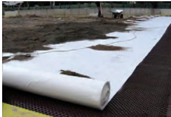
قرارگیری رول ژئوتکستایل در زیر بستر رشد
