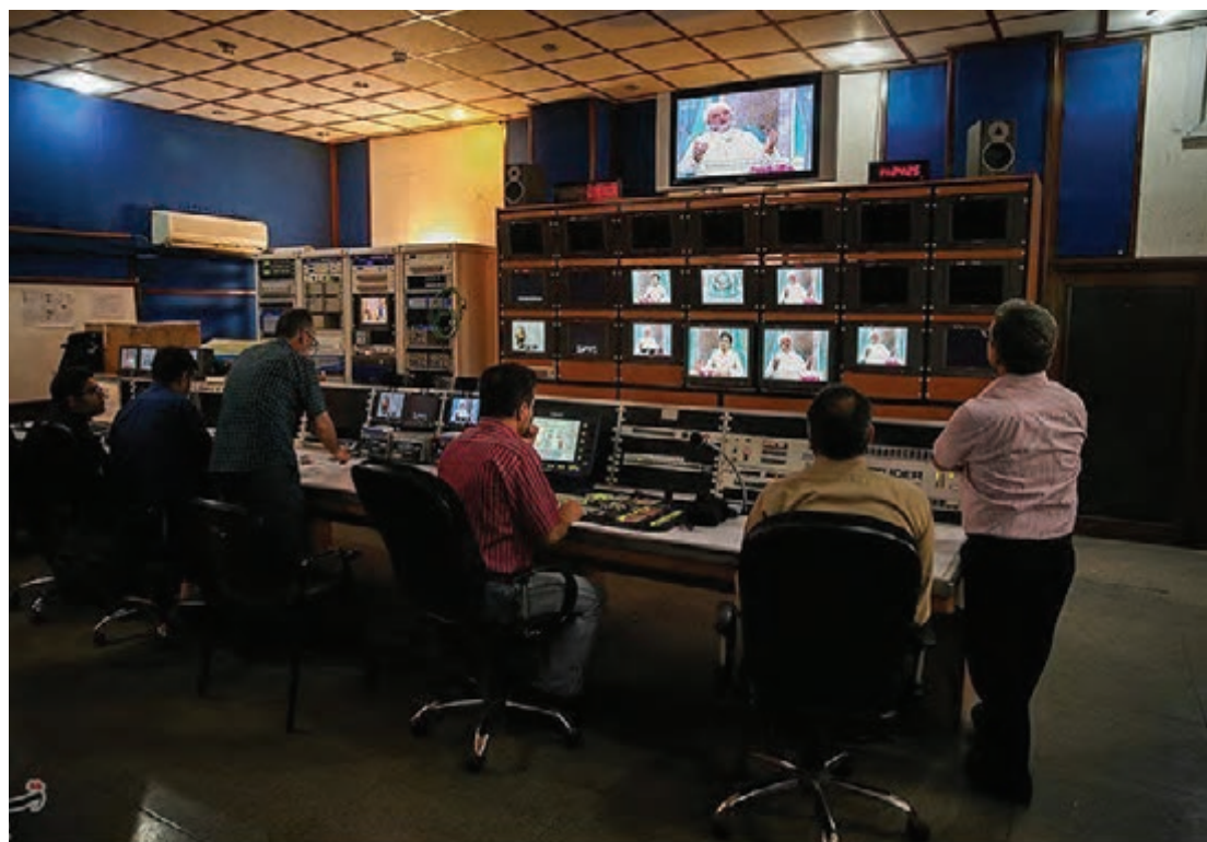
تصویر ۱۳- اتاق فرمان جهت کنترل و ضبط تصاویر دوربین‌ها
