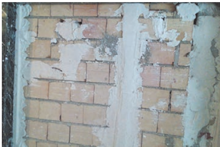
شکل ۲۴ ▲ شمشه‌گیری بین کرم‌ها
