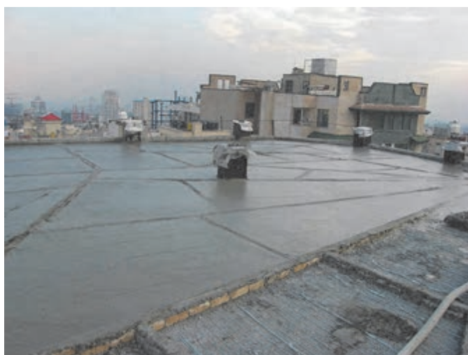
شکل ۱۵ ▲ پر کردن فاصله بین شمشه‌های سیمانی با بتن سبک
