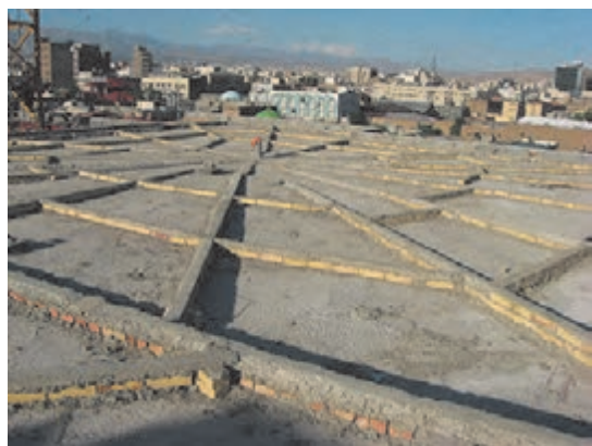
شکل ۱۴ ▲ کرم‌بندی و شمشه‌گیری بین آن‌ها
