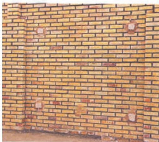
شکل ۲۱ ▲ کرم‌بندی ابتدا و انتهای دیوار
