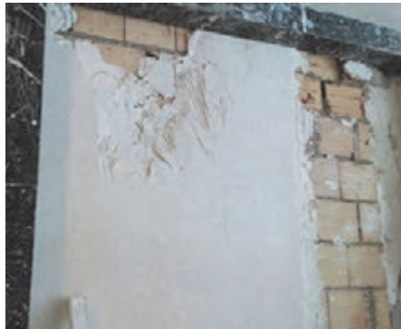
شکل ۲۵ ▲ پر کردن متن بین شمشه‌ها
