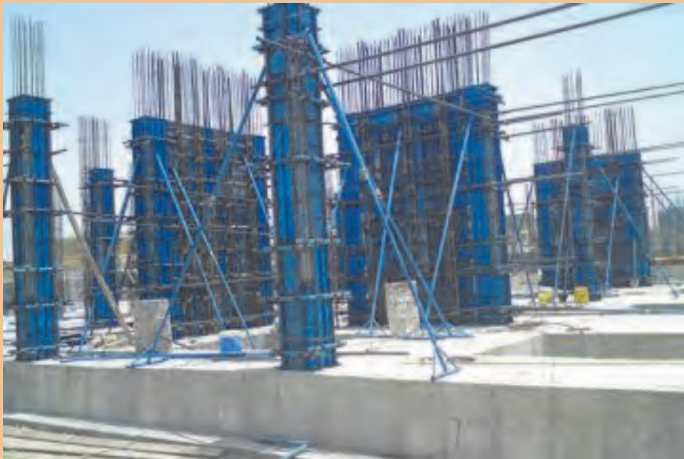
قالب‌بندی و آرماتوربندی ستون
