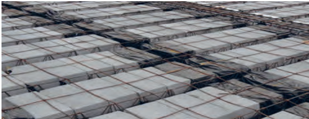
اجرای شناژ مخفی در سقف تیرچه بلوک
