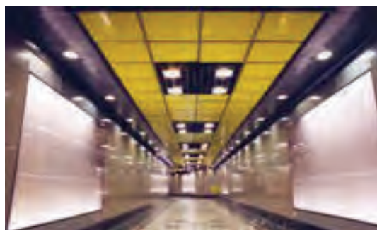
سقف کاذب تایل آلومینیومی با شبکه فلزی
