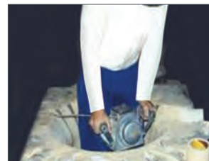
شکل ۱۳- کوبیدن نسوز کف کوره با کوبه ماشینی
