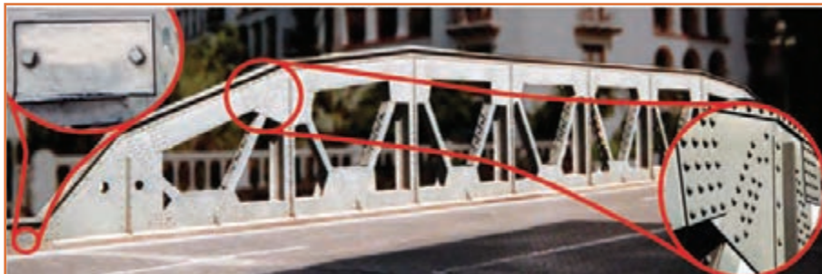
شکل ۳- اتصال دائم : پرچ
