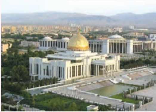
▲ کاخ ترکمن باشی در عشق آباد
