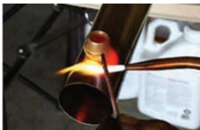
شکل ۴-۱۷- استفاده از شعله اکسی‌استیلن
