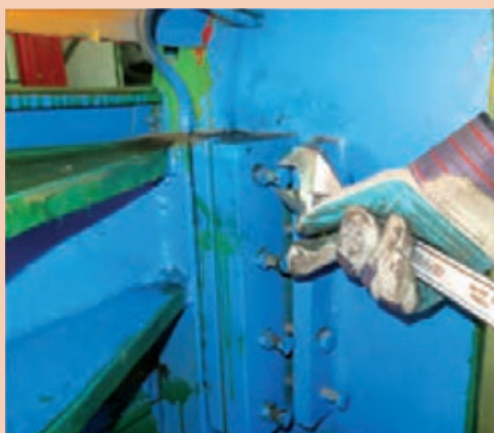
شکل ۱-۱۸- رفع عیوب برش کاری
