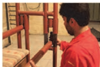
شکل ۱۷- نصب اجزاء دستگاه
