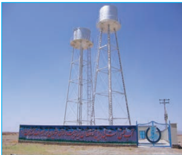
شکل ۱۰-۱۴- اجرای طرح آبرسانی بهداشتی روستایی
