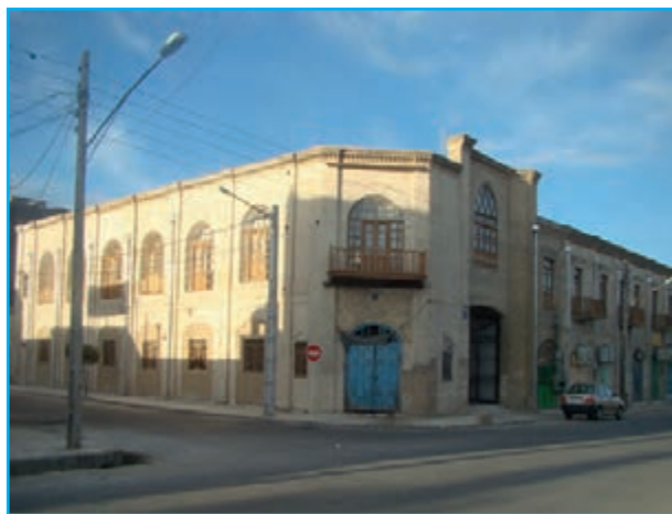
شکل ۷-۱۲- ساختمان دادگستری قدیم
