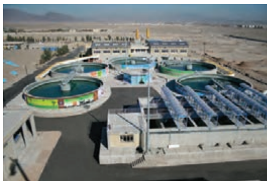
شکل ۱۳-۴ تصفیه خانه آب زاهدان
