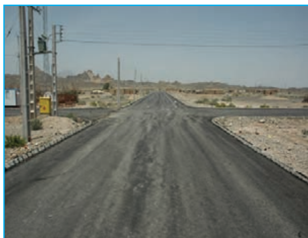
شکل ۹-۱۴- اجرای طرح‌های روستای چگرد خاش
