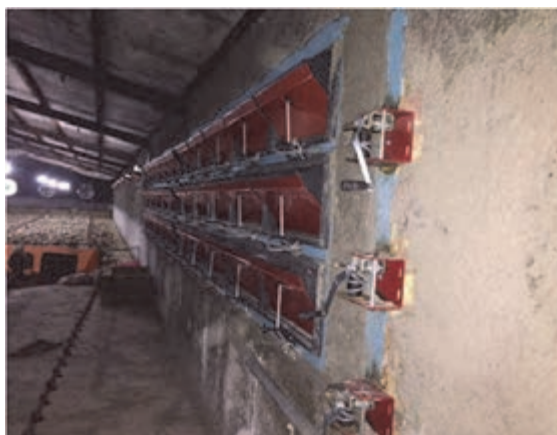
ورود هوا از طریق پنجره‌های خودکار (اینلت)
