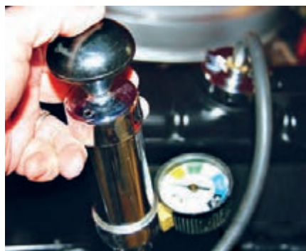
شکل ۶. آزمایش نشت یابی تحت فشار
