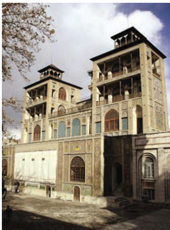
▲ شکل ۹-۱۳- شمس‌العماره، عمارت قاجاری، تهران
