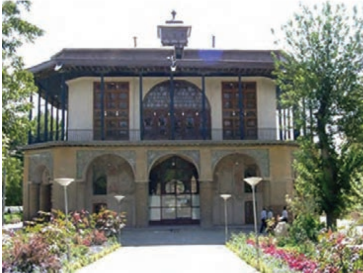
▲ شکل ۸-۱۲- عمارت چهلستون، قزوین
