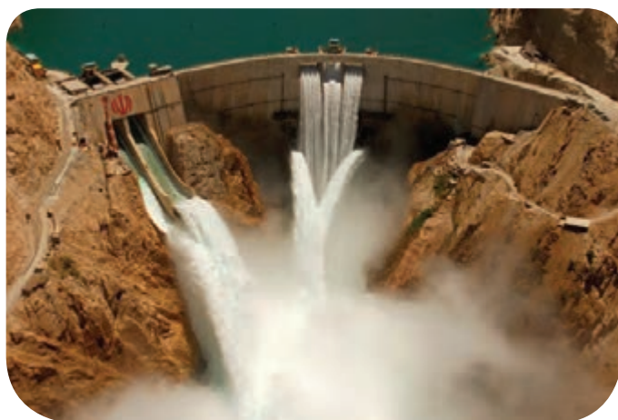
شکل ۳- سد و نیروگاه آبی کارون ۳ استان خوزستان
