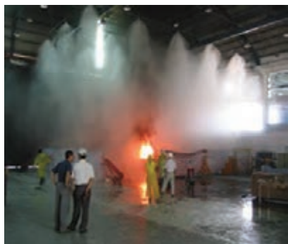
شکل ۱۱-۴- سیستم پاشش آب اطفاء حریق
