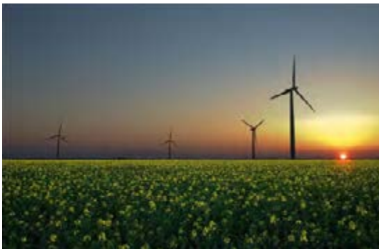
شکل ۲۶-۱۲ - یک نمونه نیروگاه برق بادی
