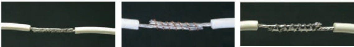
شکل ۶۰-۱- اجرای یک اتصال ساده
