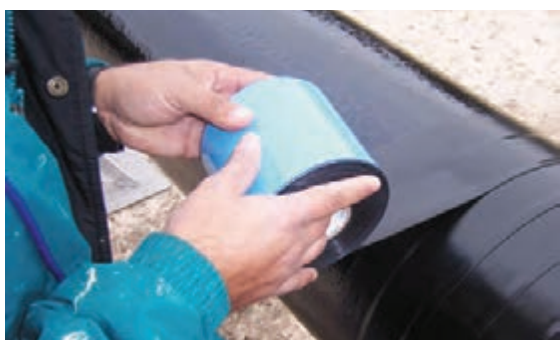
ب) نحوه پیچیدن نوار
