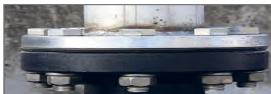
شکل ۲۹- اتصال لوله به فلنج
