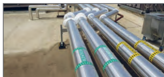
شکل ۳۴- عایق الاستومری با پوشش آلومینیوم
