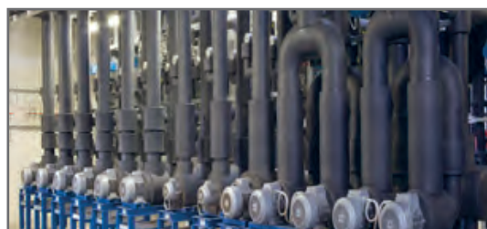
شکل ۳۳- عایق الاستومری بدون پوشش آلومینیوم
