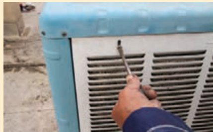
تنظیم آب پخش کن
