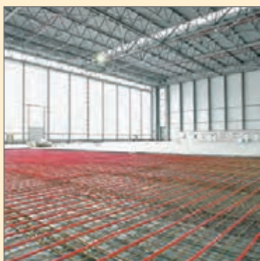
کارخانه‌ها و سوله‌های صنعتی
