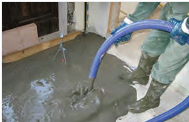
کف‌سازی ساختمان با فوم بتن
