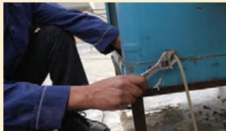
نصب لوله به شیر شناور
