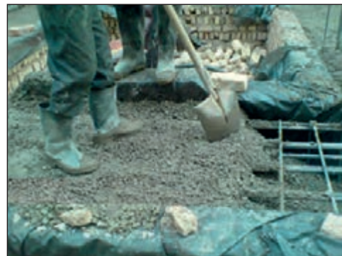
شکل ۲-۱۴۵ مرحله ی بتن ریزی داخل پی
