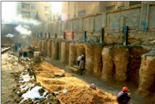
شکل ۸۸-۱ مهاربندی با پشت بند خاکی ستونی
