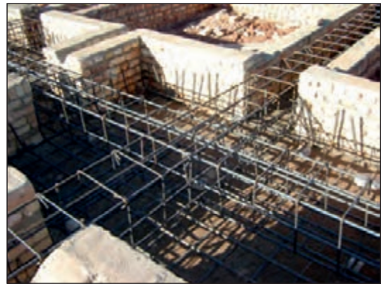
شکل ۷۱-۲ عبور میلگردهای شناژ در پی
