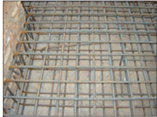
شکل ۱۴۷-۲ پی نواری و آرماتورگذاری آن
