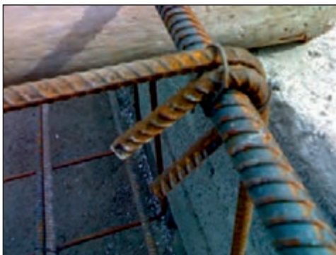
شکل ۲-۱۴۲ قلاب سرخاموت و بستن آن با مفتول
