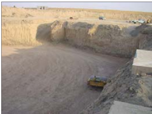
شکل ۸۴-۱ زمین گودبرداری شده
