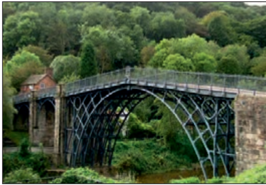
شکل ۱-۲ پل رودخانه سورن در انگلستان
