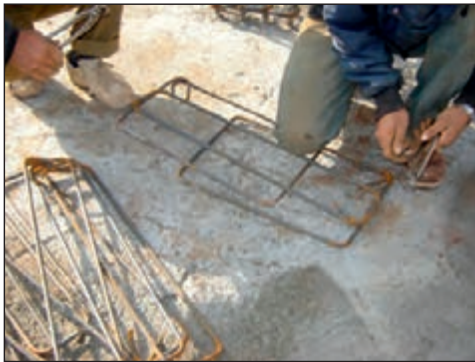
شکل ۲-۱۴۰ خم آرماتور و ساخت خاموت
