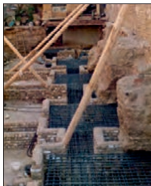
شکل ۹۰-۱ مهاربندی با شمع چوبی
