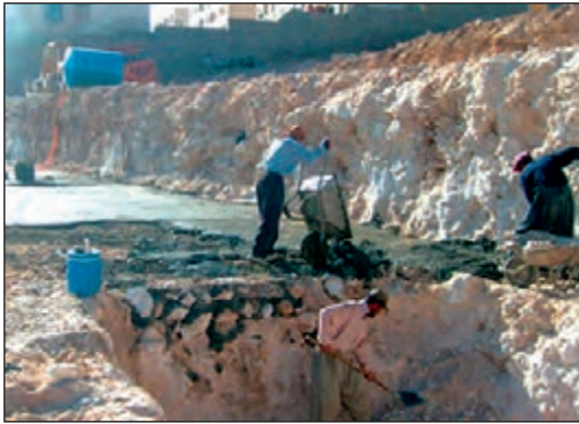
شکل ۸۷-۱ گودبرداری دستی (با بیل و کلنگ)
