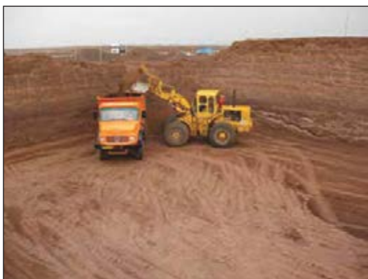
شکل ۸۵-۱ گودبرداری با لودر در زمین نامحدود
