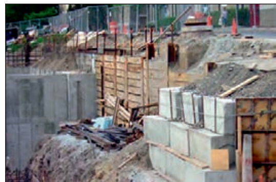
شکل ۹۱-۱ مهاربندی با دیوار مانع چوبی
