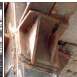
اتصال تیر به ستون به صورت لچکی
