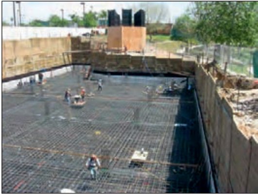
شکل ۱-۶۲ پی بتن مسلح یکپارچه (رادیه ژنرال)
