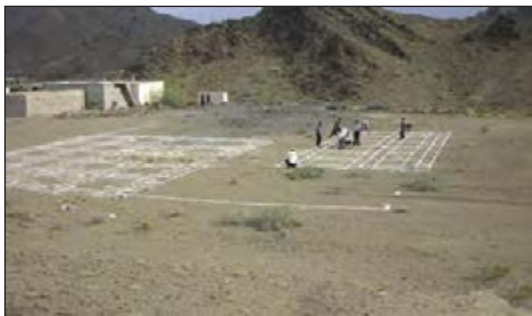
شکل ۸۳-۱ پیاده کردن نقشه روی زمین
