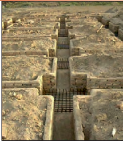
شکل ۴۸-۱ آرماتورگذاری پی تکی کلاف بندی شده
