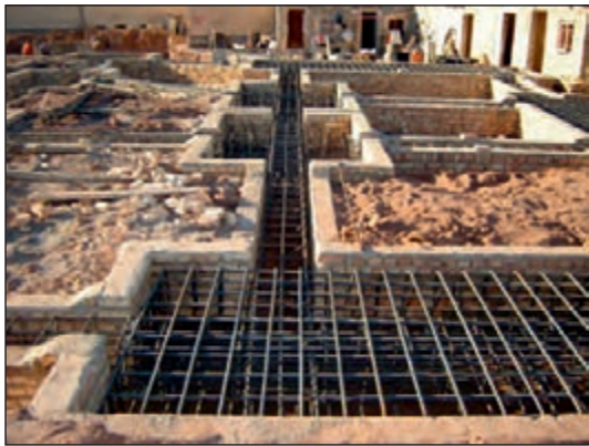
شکل ۷۰-۲ میلگردگذاری در پی کلاف بندی
