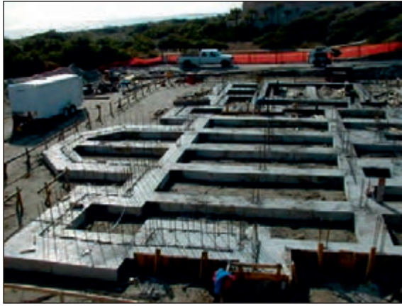
شکل ۱-۵۶ پی بتن مسلح نواری شبکه ای زیرستون
