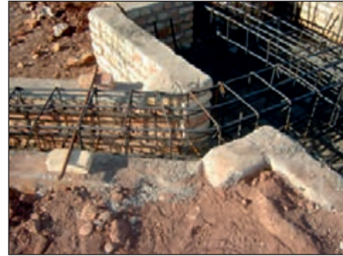
شکل ۲-۱۴۳ آرماتورهای شناژ و پی
