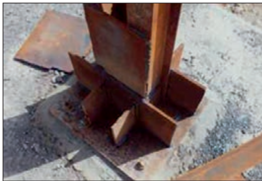
شکل ۱۶۸-۲ اتصال گیردار
