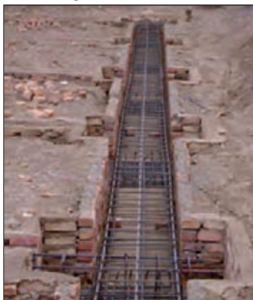
شکل ۷۲-۲ پی و شناژ قبل از بتن ریزی
