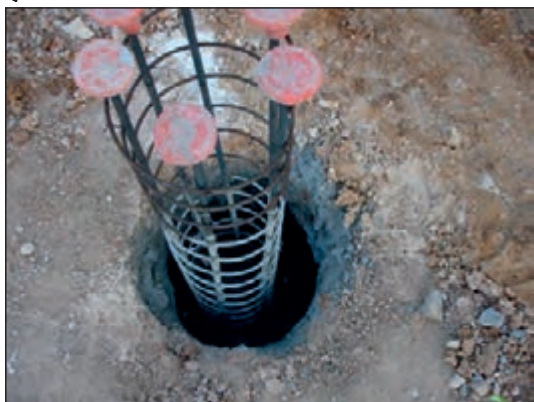
شکل ۱-۷۳ پی چاهی در حال اجرا
