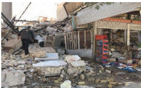
شکل ۱- زلزله ۷ ریشتری کرمانشاه
