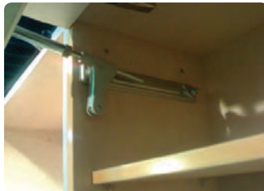
شکل ۶-۳۷ در کابینت نصب شده با نگه‌دارنده پمپی
