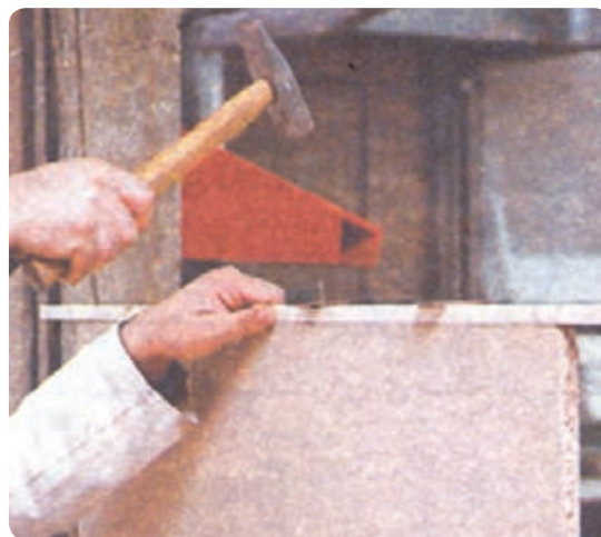
شکل ۶-۷۸ نصب زهوار چوبی لبه چسبان
