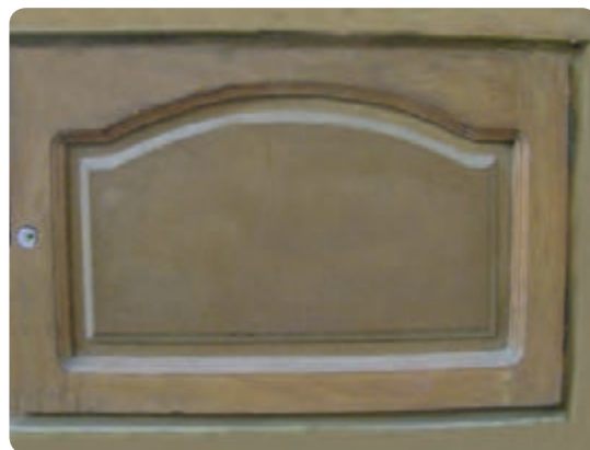
شکل ۶-۸۷ در قاب و تنکه‌ای کابینت
