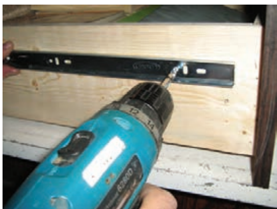
شکل ۷-۳۶ نصب ریل بر روی بدنه‌ی کشو
