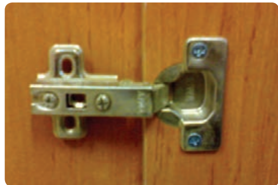
شکل ۸۵-۶ نصب کاسه لولا روی در کابینت
