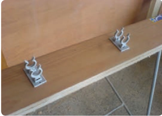
شکل ۶-۶۵ اتصال کلیپس پاسنگ به پایه کابینت
