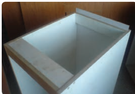
شکل ۶-۷۵ مونتاژ کابینت با قرارگیری پشت‌بند
