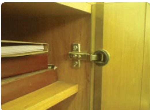
شکل ۶-۴۱ در شیشه‌ای با لولای فنردار مخصوص شیشه
