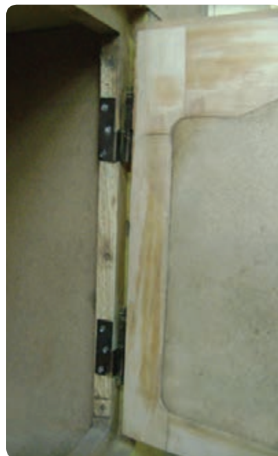
شکل ۶-۸۸ در قاب تنکه‌ای با لولای قابل‌مهم‌ای
