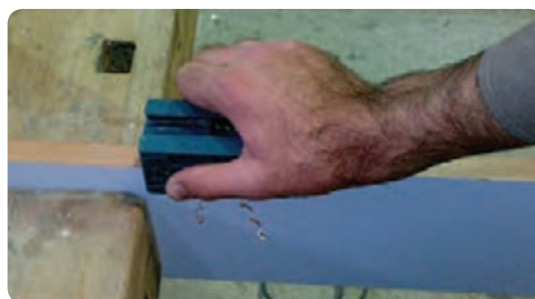
شکل ۶-۸۲ پرداخت لبه اضافی روکش
