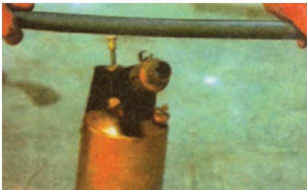
شکل ۴-۴۳- حرارت دادن لوله‌ی PVC
