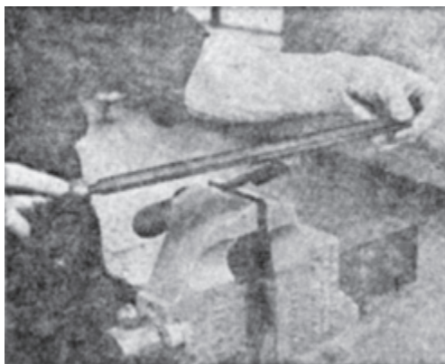
شکل ۱-۴۰ - تمیز کردن هویه
