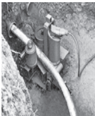
شکل ۵-۵۱- دستگاه کشش کابل
