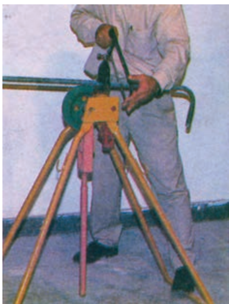
الف - بریدن لوله توسط اره
