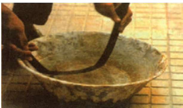
شکل ۴-۴۵- سرد کردن لوله پس از خم‌کاری
