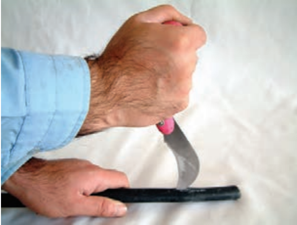
الف - نحوه‌ی غلط لخت کردن کابل
